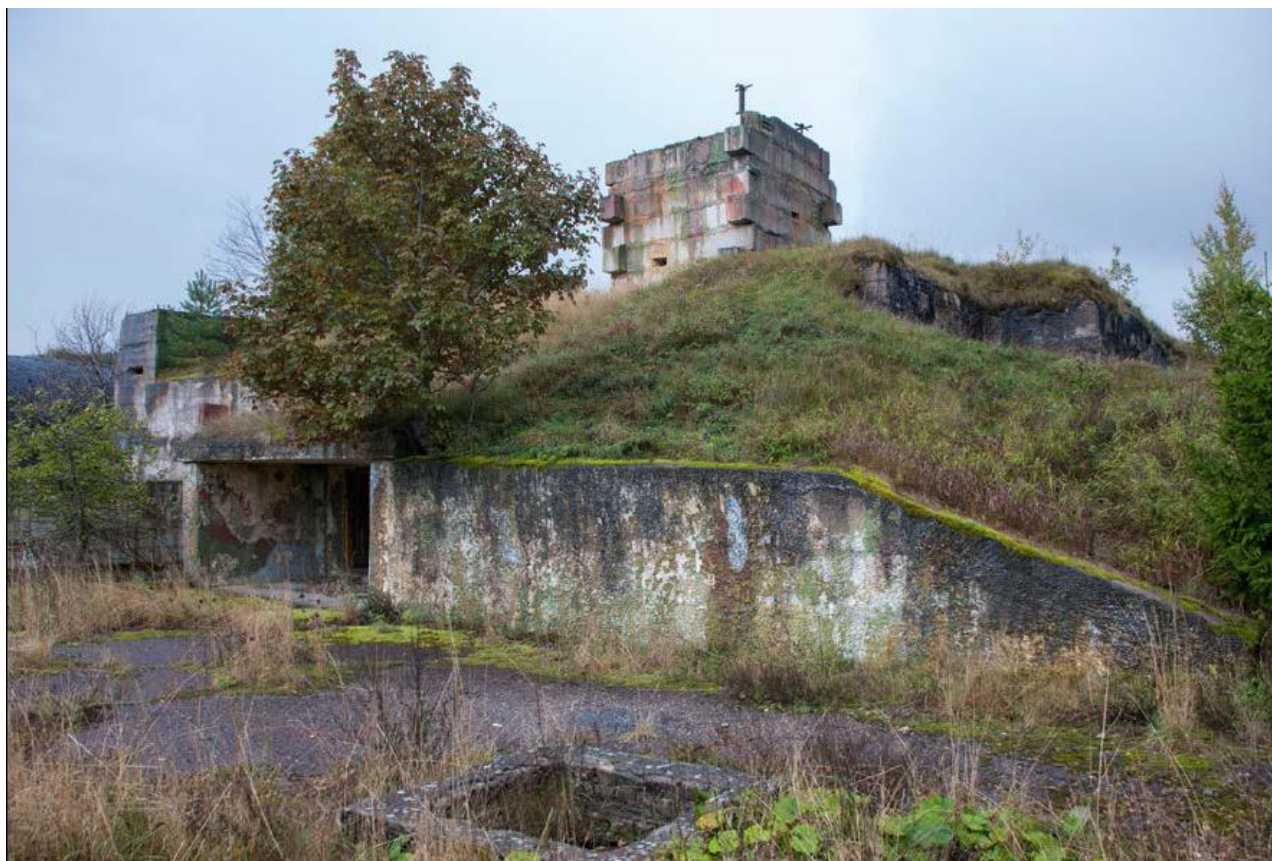
Foto 10. Vaade KP peasissekäigule põhjast. Foto Mart Mõniste 27.09.2013.
