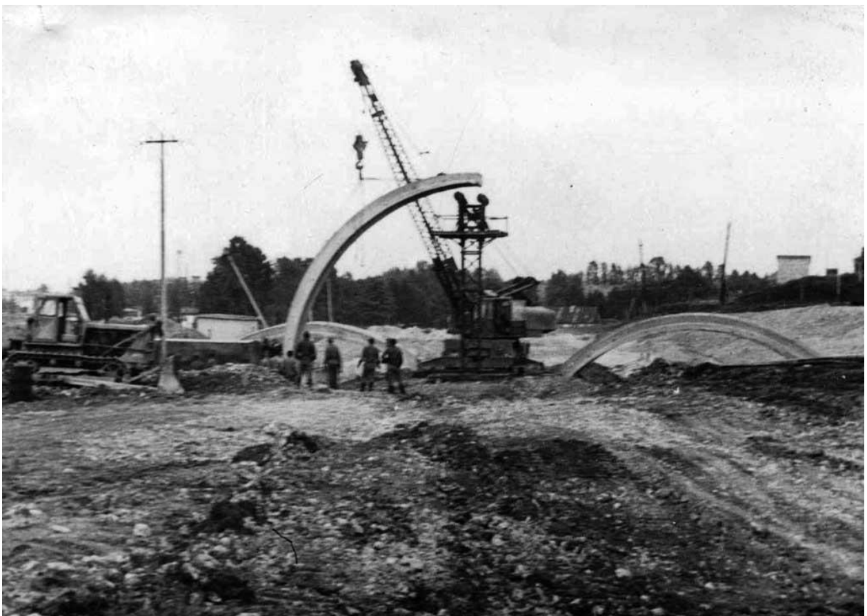
Foto 8. Rakvere 207. seniitraketibrigaadi KP esimese kaare paigaldamine 02.06.1979 (analoogiline kaarvarje [2] püstitamiseks). Allikas: http://14dpvo.ucoz.ru/photo/albom_eremenko_bn_kp_207_zrbr/68 , Альбом Еременко Б.Н.
