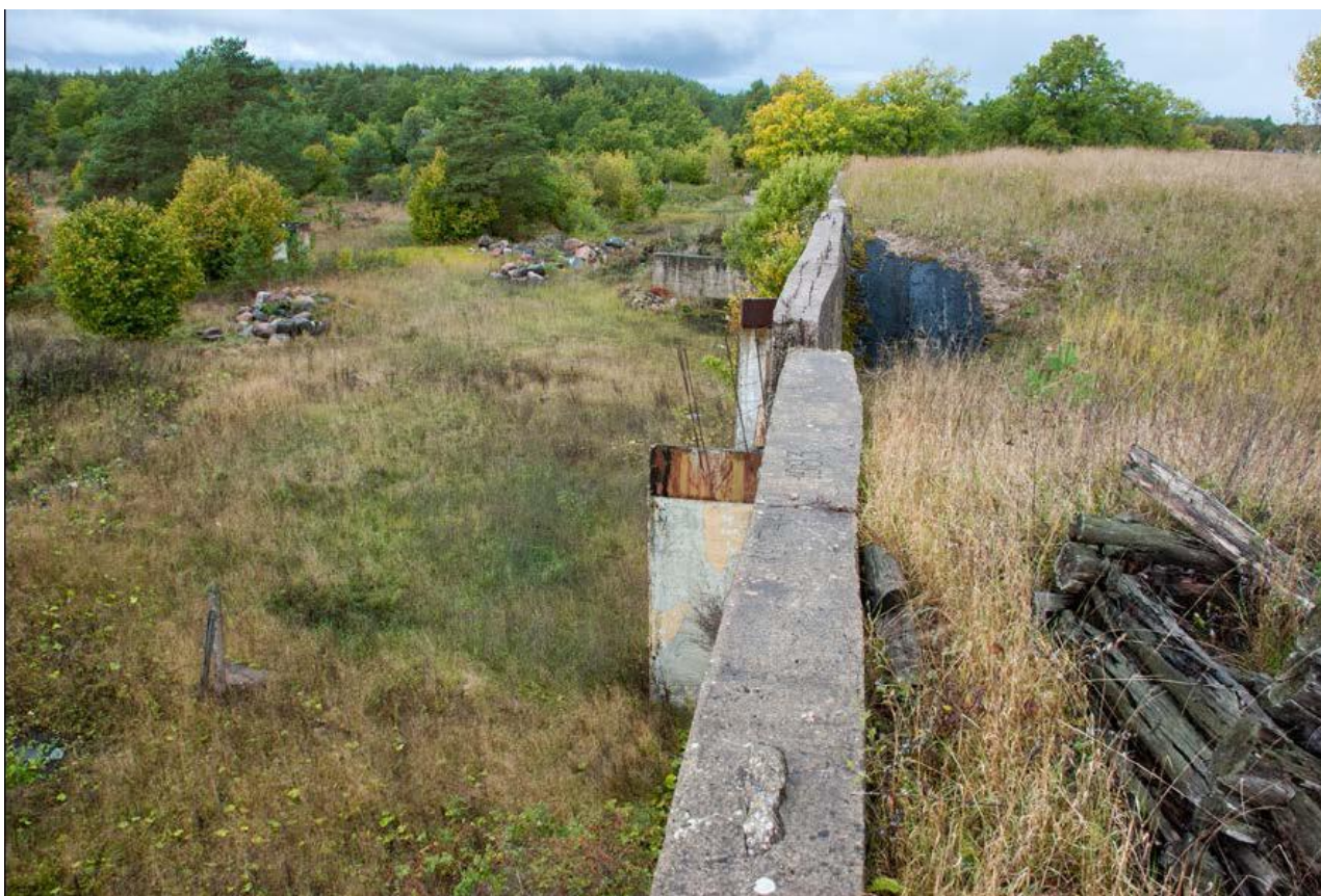
Foto 12. KP tagasein (edelapoolne), vaade kagust. Kõik 3 kaitsevõravad on alles. Näha on kahe kaarvarje ühenduskoht – tagapool vanem ja kõrgem ning eespool uuem ja madalam pikk angaar. Viimase tagaseina betoonis on aastaarv „1983”. All paremal puidust visuaalvaatlusposti/laskepessa jäänused. Foto Mart Mõniste 27.09.2013.
