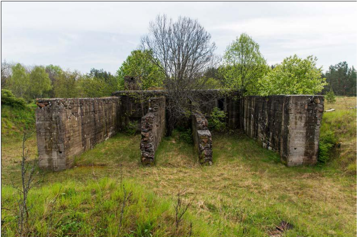
Foto 32. Komandopunkt aparaadikabiinide boksidega (joonis 8, 3), vaade läänest. Paremäl radariküngas. Bokside tagaseintes sissepääsud punkrisse. Foto Mart Mõniste 19. mai 2014.
