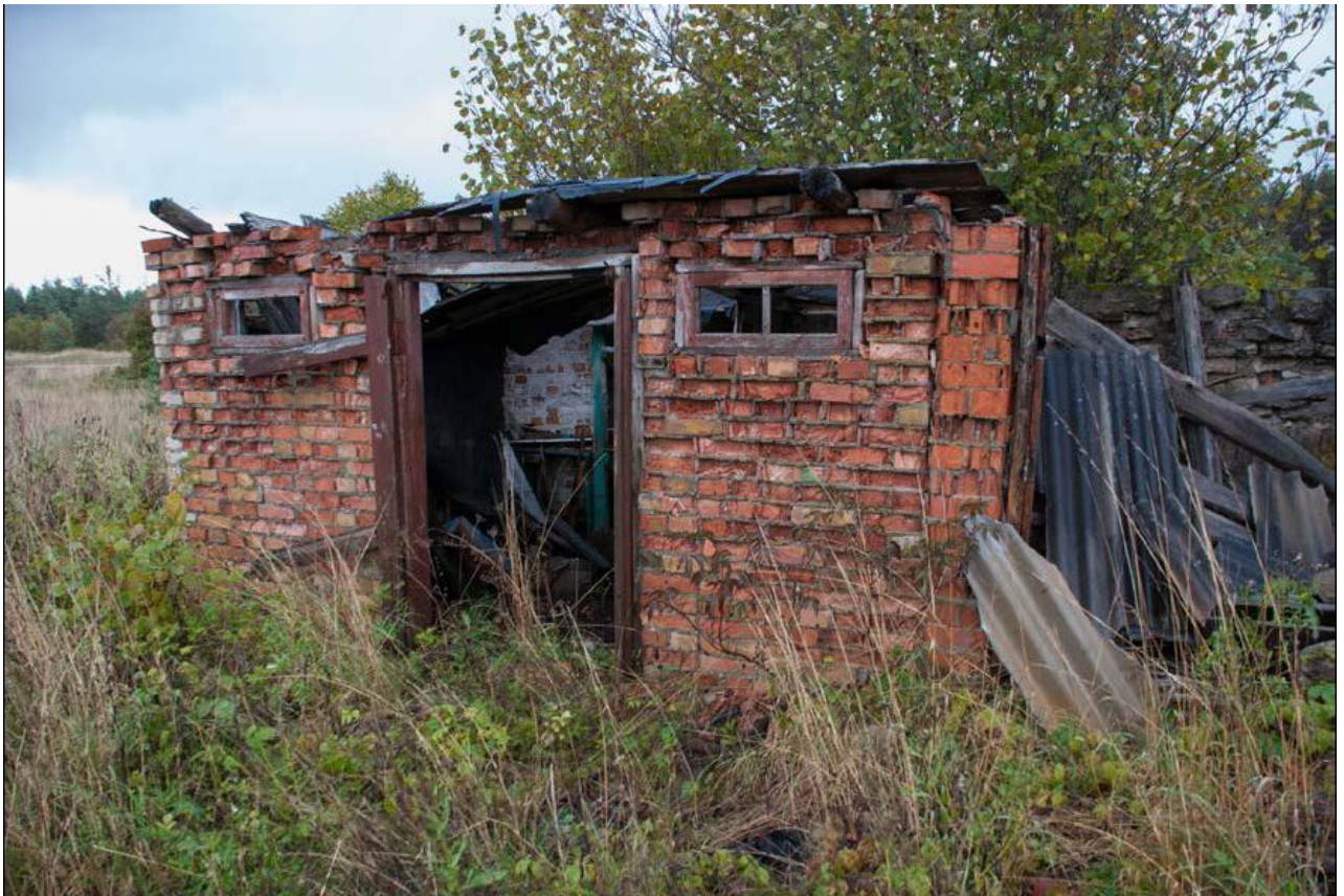
Foto 25. Hoone [8] on ehitatud punastest tellistest ja paekividest. Foto Mart Mõniste 27.09.2013.
