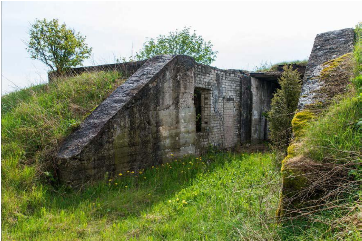
Foto 38. Radari P-12 või P-15 varje meeskonnavarjendiga (joonis 8, 10). Taga paremal paistvas radariboksis paiknes auto ZiL-157, mille katusel oli masti otsas radari antennisüsteem. Viimase jaoks on katusesse raiutud sisselõige. Kummalgi pool radariboksi ees oli algselt kaks katusetä põikiboksi, millest vasakpoolne on kinni ehitatud. Rajatise kirdeküljes on veel üks masinaboks. Foto Mart Mõniste 19.05.2014.
