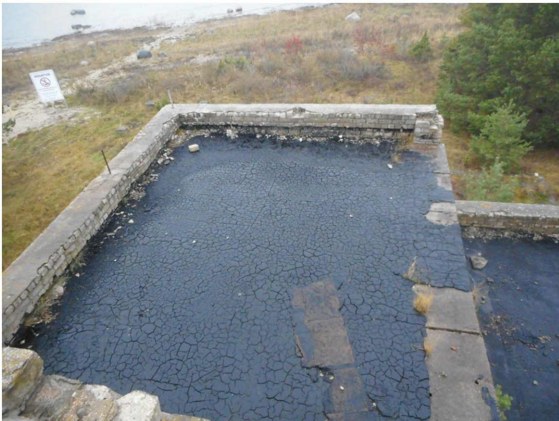
Foto 22. Komplekshoone katus (8.11.2017). Vasakul on rõdupiirdepostid alles. Merepoolse rinnatise külge oli kinnitatud raadioantennimast.
