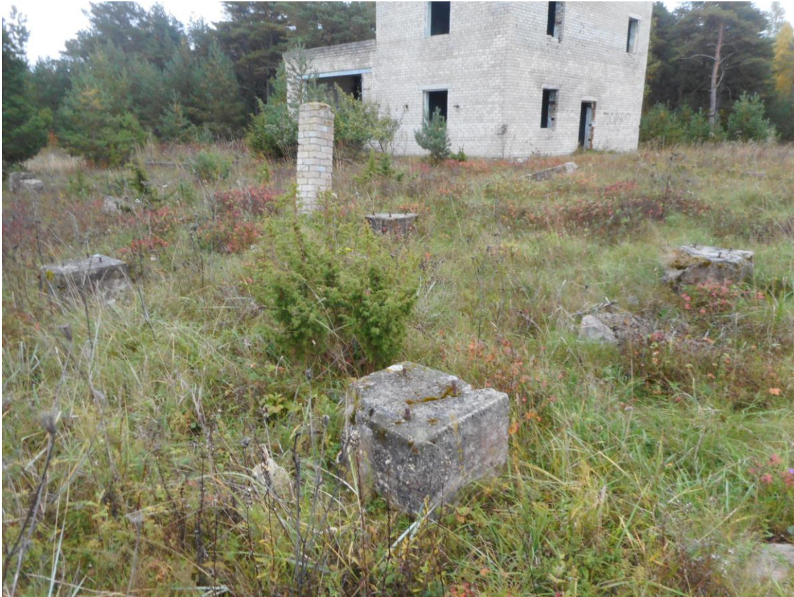
Foto 26. Torn (joonis 4, nr 4) betoonalused (7.10.2017). Pisut lagunened, aga täiesti kandeõimelised ning neid saaks mingil otstarbel ära kasutada (2011.a detailplaneeringus on määratud nad lammutamisele). Torn trepialusel on aastaarv 1968.
