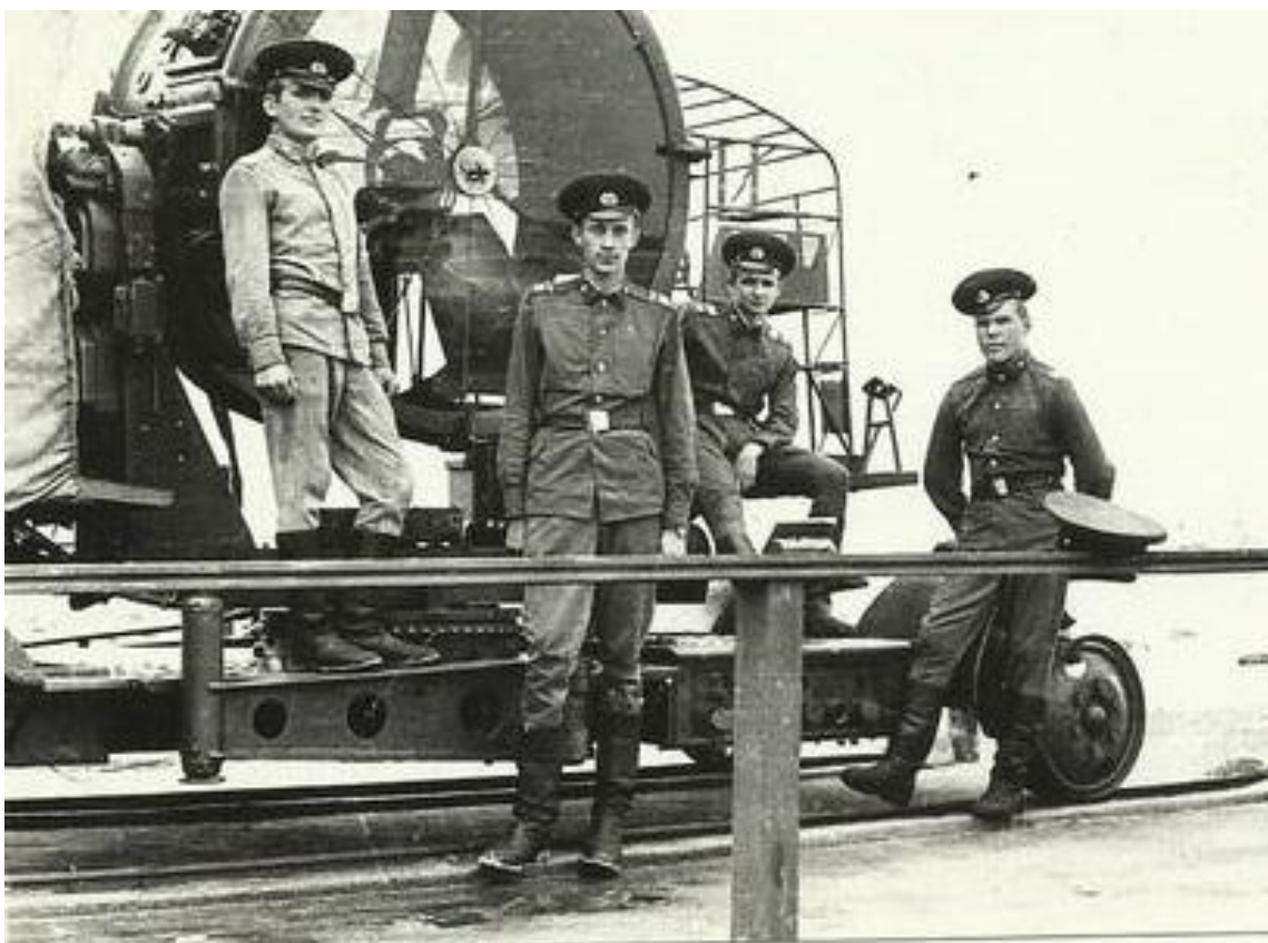
Foto 6. Prožektorijaam RP 15-1 (150 mm-ne) Ramsi TVP vanal positsioonil, metallrelssidel. Piirde puitpostid olid valatud betooni sisse. Foto valdaja Кривец (teenistusaeg Paslepa kordonis 02.1976– 05.1977), http://www.pogranec.ru/showthread.php?t=29576&page=13 .
