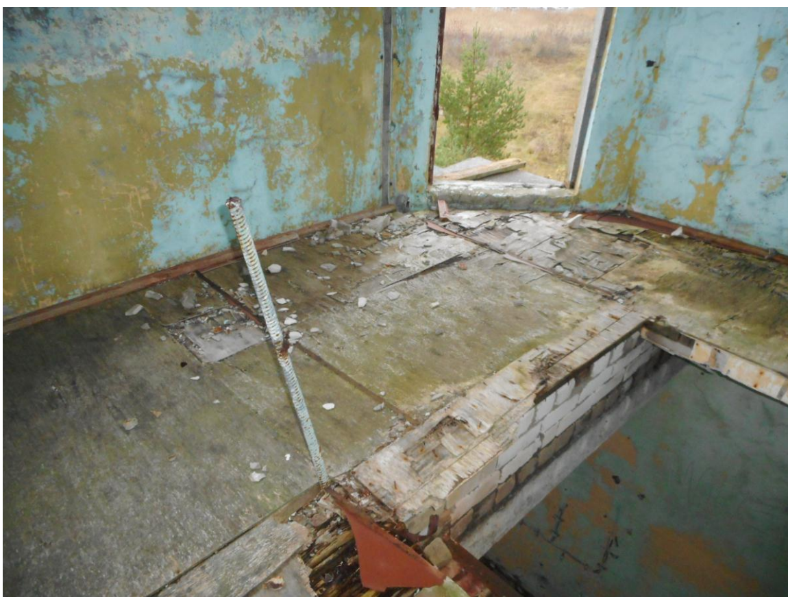
Foto 20. Visuaalvaatlusruumi vineerpõrandas on mõned augud, aga kannatab veel peal käia. Põrandapind on paneelist u 40 cm kõrgusel. (8.11.2017)
