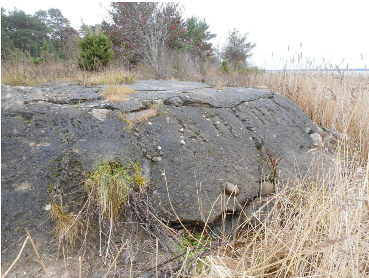
Foto 33. Vana prožektoripositsiooni (joonis 4, nr 3) ots mere poolt (8.11.2017). Betooni sisse on kividega jäädvustatud kiri „СЛАВА САПЕРАМ!“ („Au sapööridele!“) ning aastaarv 1958. Positsiooni ääred on mitmes kohas tükkideks eraldunud, need saab aga uuesti kokku panna.
