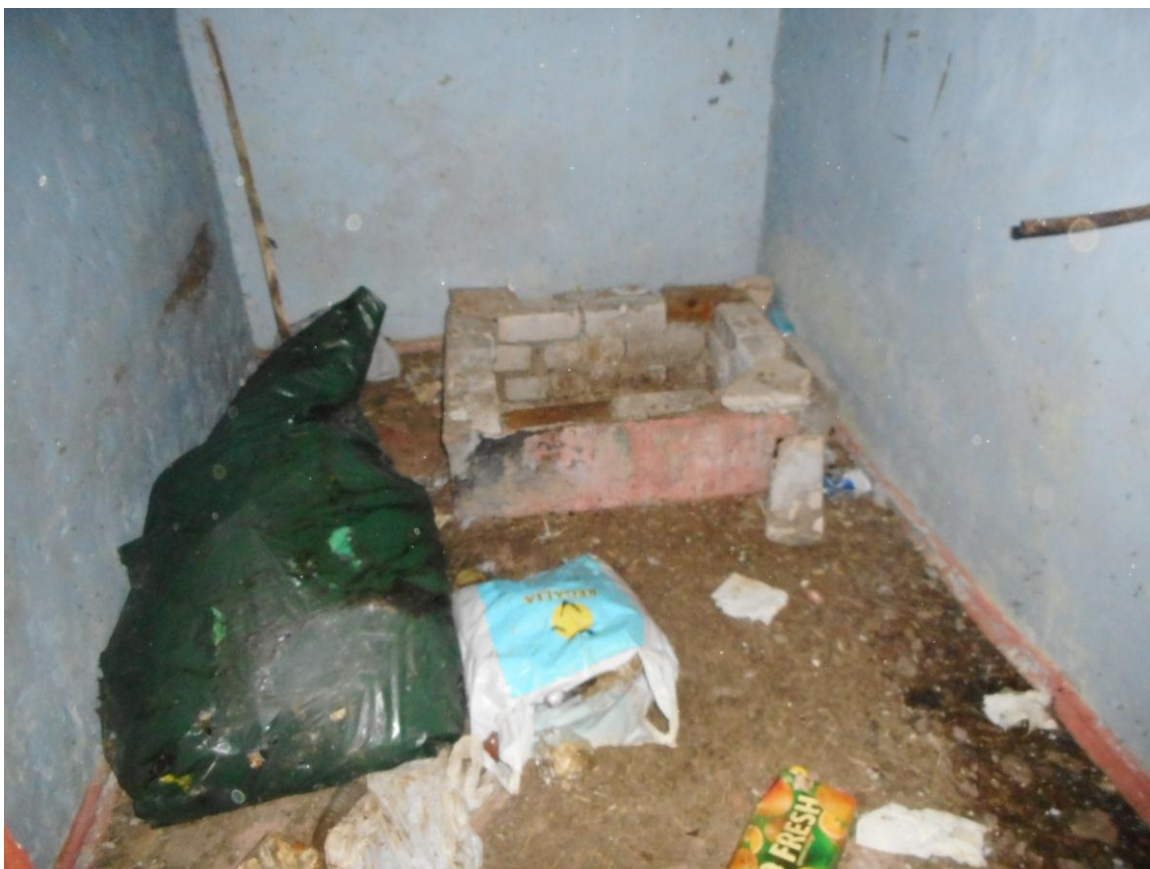
Foto 14. Tagumine väike ruum prožektoriruumi taga – ilmselt tualettruum (8.11.2017). Tagaseina juures silikaatkividest u 2 m sügavune auk (sellest pärineb fotol kujutatud praht), mis oli pealt kaetud õhukese betoonkattega. Parempoolses seinas on kaks kraanikausi tugitoru.
