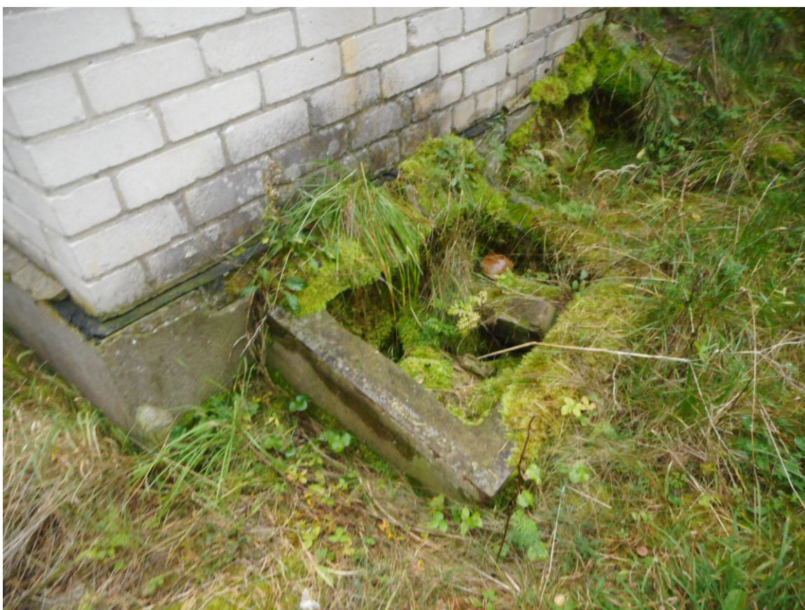
Foto 16. Komplekshoone kagunurgas välisukseava kõrval klosetiruumi vastas on ilmselt lampkast (7.10.2017).
