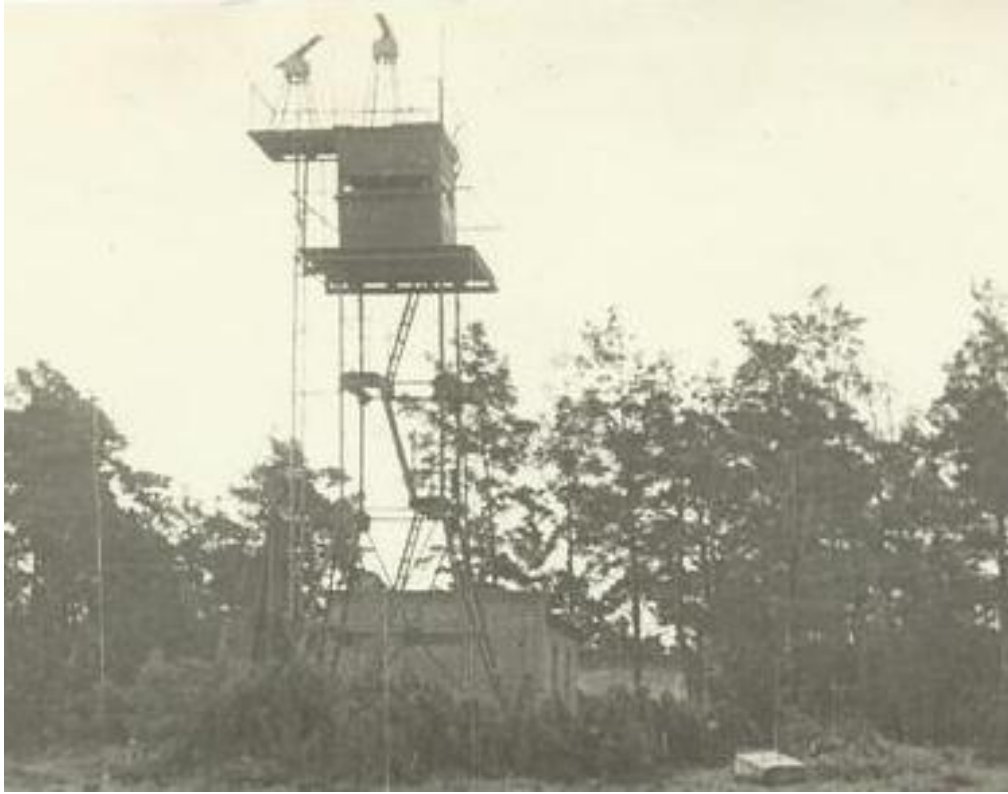
Foto 3. Ramsi TVP u 1977.a, vaade mere poolt. Torni katusel 2 radariantenni. Torn on tavalisest madalam, nelja trepikäiguga, vaatlusruumi põranda kõrgus u 10 m, ülemise platvormi kõrgus u 13 m. Taga paistavad vana operaatorihoone ja diislihoone. Foto valdaja Кривец (teenistusaeg Paslepa kordonis 02.1976– 05.1977), http://www.pogranec.ru/showthread.php?t=29576&page=13 .
