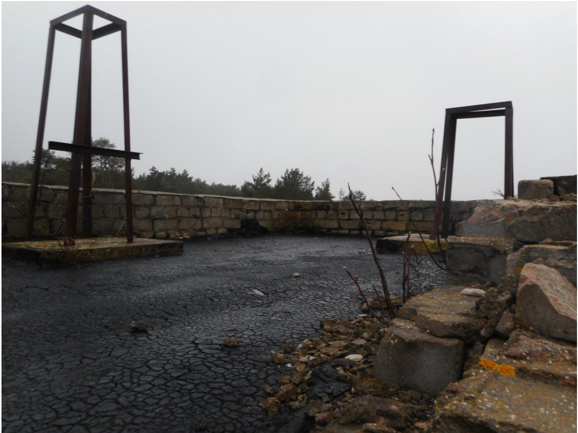
Foto 23. Visuaalvaatlusruumi katus kahe radariantennialusega (8.11.2017). Siin oli rinnatis piireteta.
