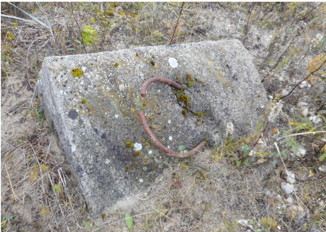
Foto 27. Torn (joonis 4, nr 4) tõmmitsaankur (7.10.2017). Kolmel ankrul neljast on pingutustrossi kinnitusaas läbi lõigatud.
