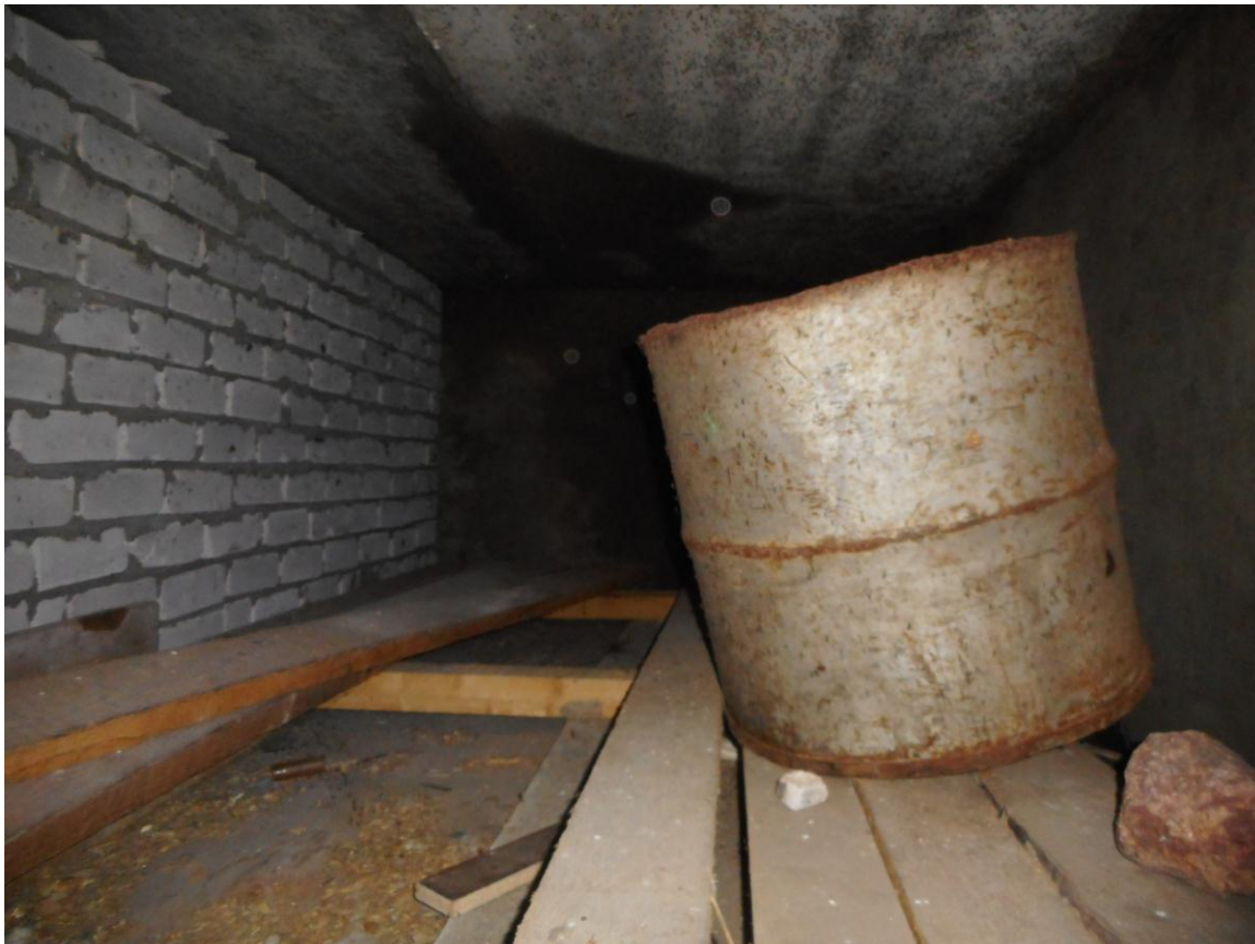
Foto 15. Prožektoriruumi taguste tubade peal on u 1 m kõrgune laudpõrandaga ruum, kuhu pääseb luugi kaudu. (8.11.2017). Paremalt 200-liitrisest vaadist tehtud veepaak, millest viib toru alla kunagise kraanikausini.
