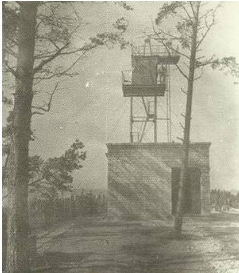
Foto 4. Ramsi TVP u 1977.a, vaade maa poolt. Vana operaatorihoone (veel 1987.a oli alles) ja torn (kahe vaheplatvormiga, eenduva katuserõduga). Foto valdaja Кривец (teenistusaeg Paslepa kordonis 02.1976– 05.1977), http://www.pogranec.ru/showthread.php?t=29576&page=13 .
