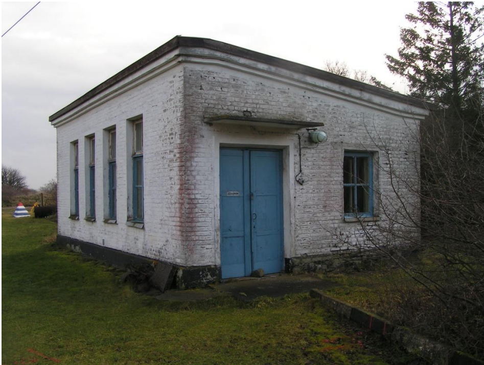
Foto nr 1: Diiselektrijaama üldvaade loode poolt vaadatuna.
