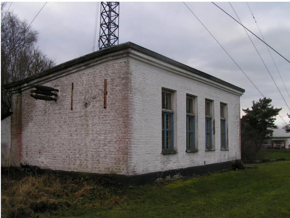
Foto nr 2: Diiselektrijaama hoone kagust.
