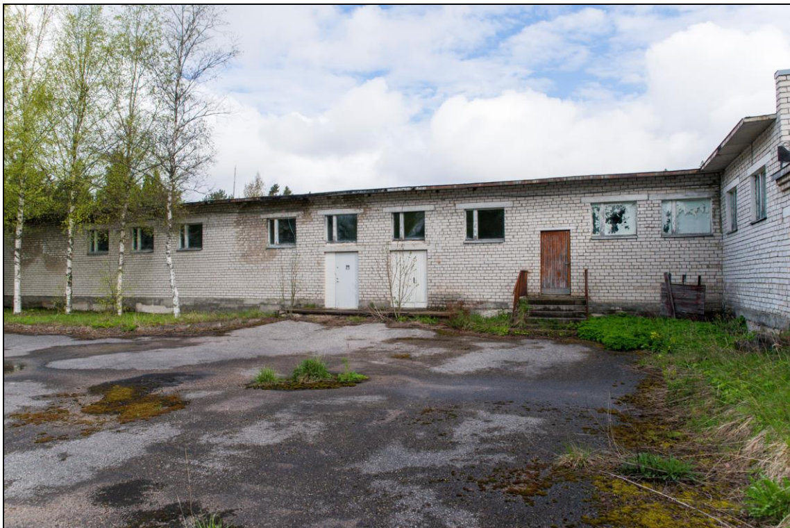
Foto 15. Tuksi kordon. Vaade garaazide tiivale [2] sisehoovist, paremal katlamaja tiib.
