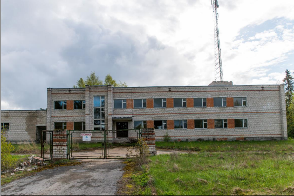
Foto 1. Tuksi kordon. Kordoni komplekshoone [1], vaade sissesõiduteelt.
