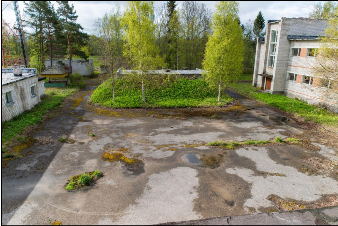
Foto 18. Tuksi kordon. Vaade sisehoovile garaažide [2] katuselt, keskel kelder [4].
