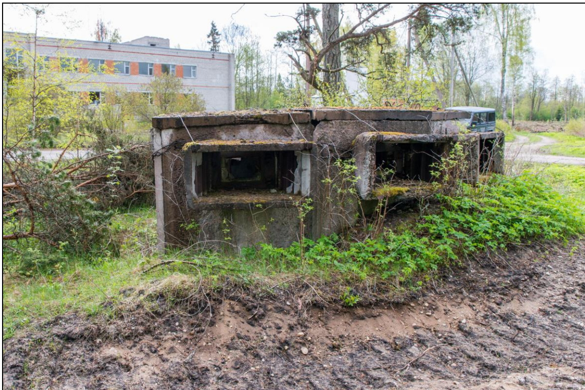
Foto 35. Tuksi kordon. Dott [16] SPS-3 (СПС-3 сборное пулеметное сооружение).
