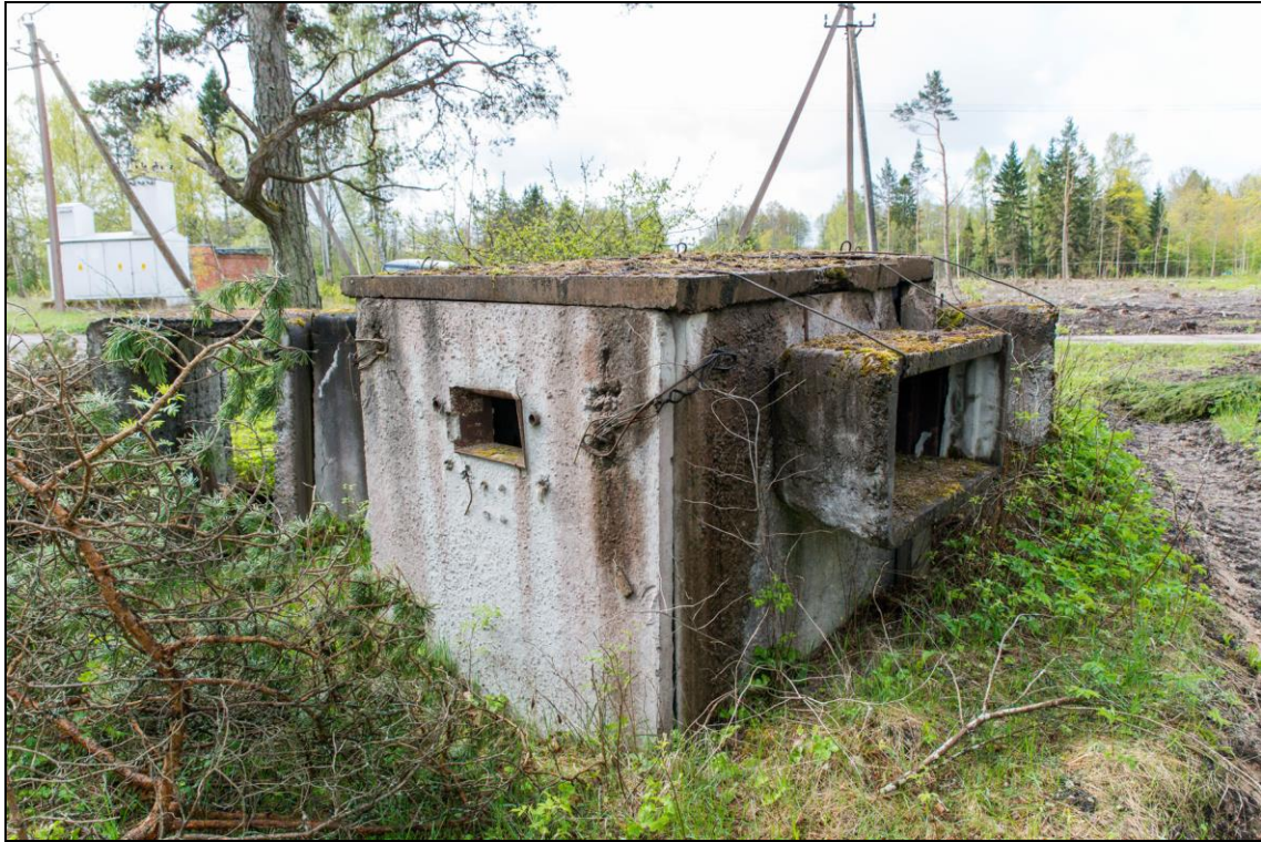
Foto 36. Tuksi kordon. Dott [16]. Ambrasuuride ees olevate laienduse mõõtmed: 128 x 63 cm, sügavus 53 cm, seina paksus 7 cm.
