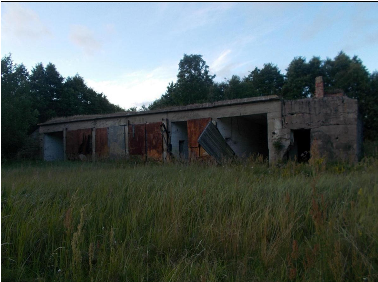
Foto 25. Kõetav raketihoidla („rajatis 7”) [68], vaade edelast.
