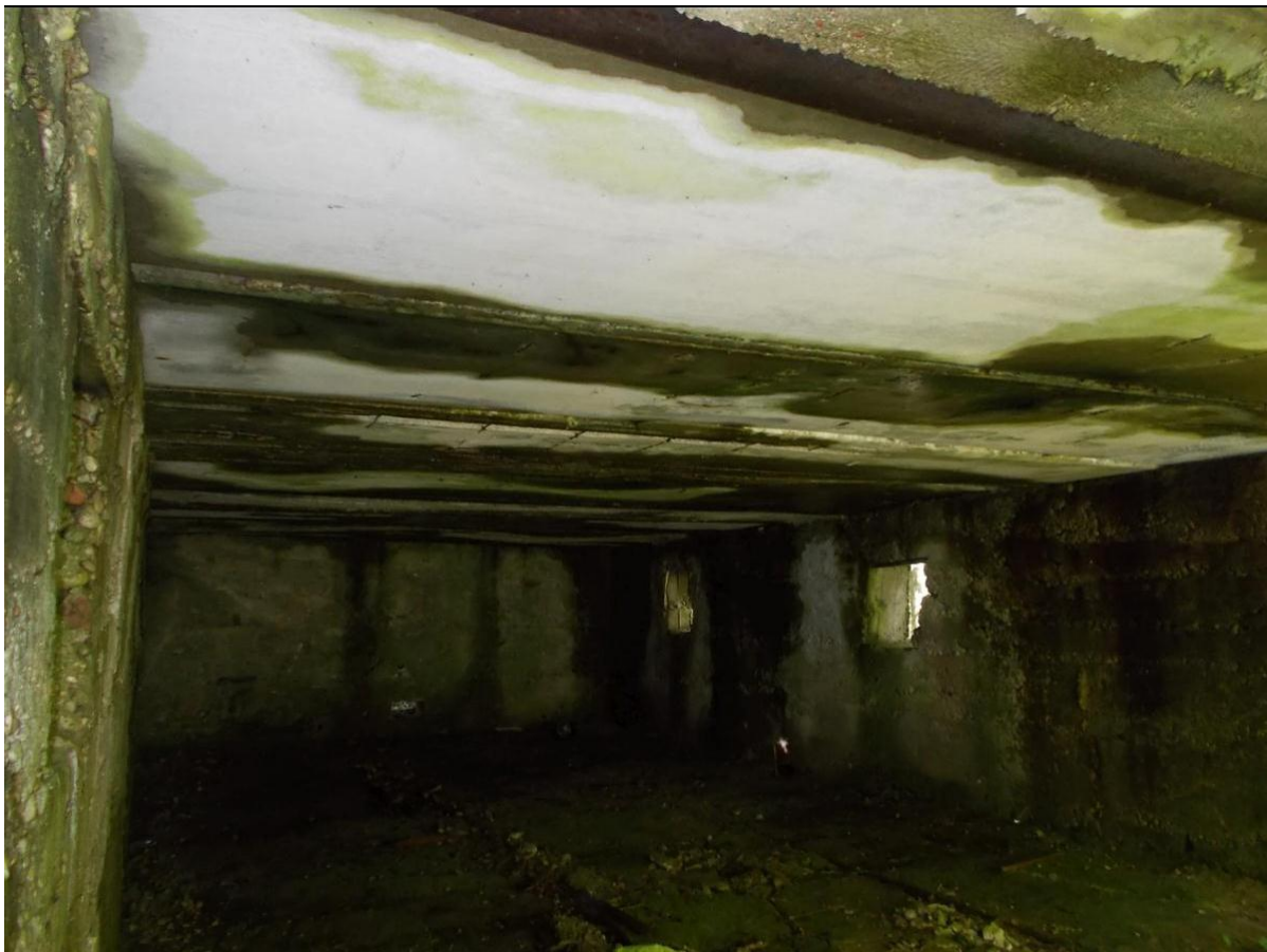
Foto 38. Väljaku nr 10 betoonhoone [108] (II–III lahingukomplekti rakettide hapendiga? tankimiseks).
