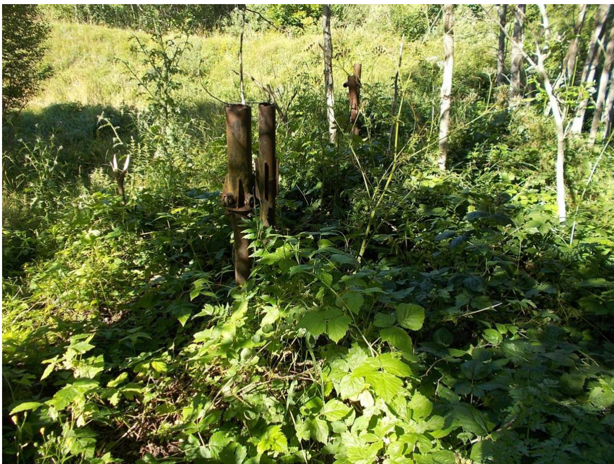
Foto 39. 3. laskeseadme positsioon [109]. Seest võsastunud, nagu teisedki. Vallil on säilinud maskeerimisvõrgu? mastide metallist paarispostid, betooni valatud.
