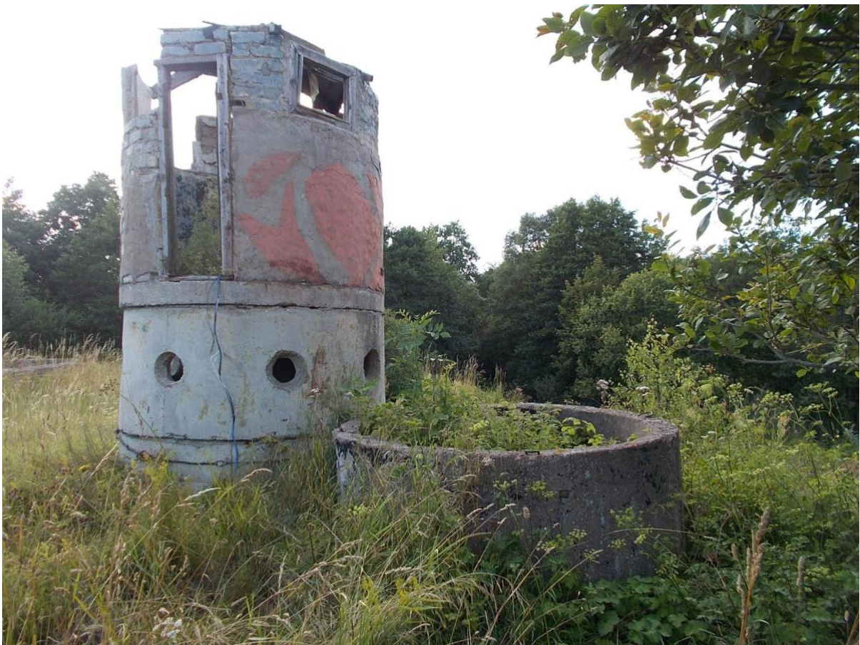
Foto 35. Komandopunkti [80] lael on dott-visuaalvaatluspost ja selle kõrval teadmata otstarbega u 1,8 m läbimõõduga betoonist kaevurõngas.
