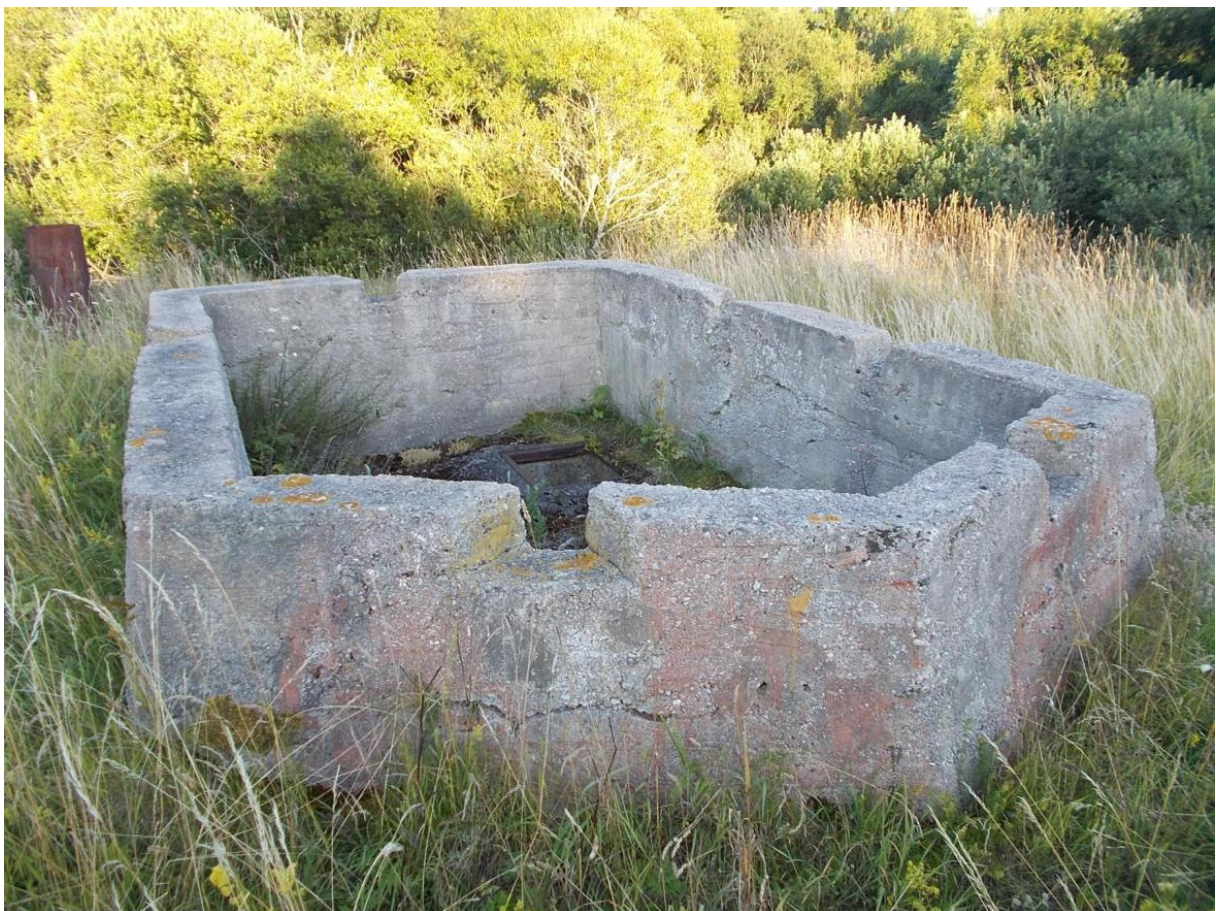
Foto 33. Arvatavasti seniitkuulipildeseadme NSV positsioon komandopunkti [80] lael. Rajatise tagaservas paistab luugiava.
