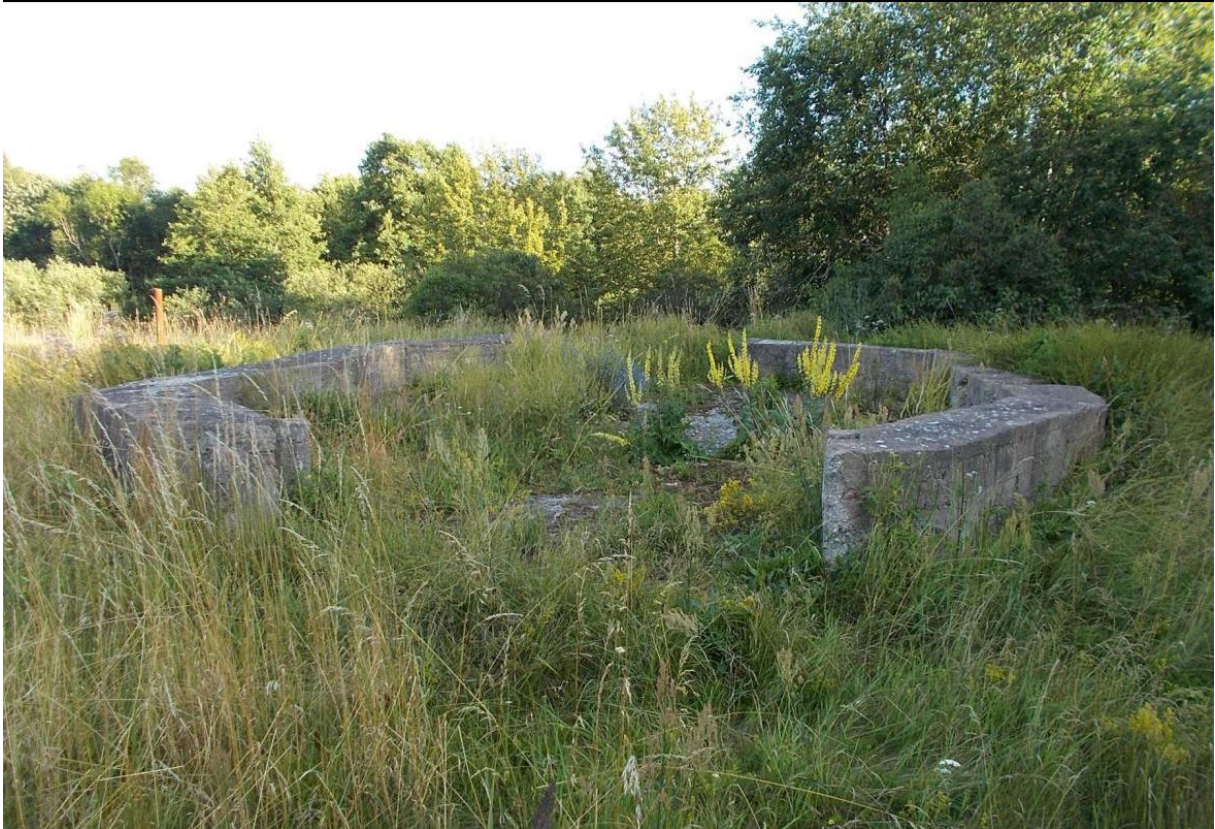
Foto 34. Otse komandopunkti [80] lääneseina kõrval on kungas raketisuunamisjaama antenniposti jaoks. Selle ümber on ehitatud 0,5–0,7 m kõrgune plaanilt 8-kandiline betoonist varje? või (nt puidust) varje vundament.
