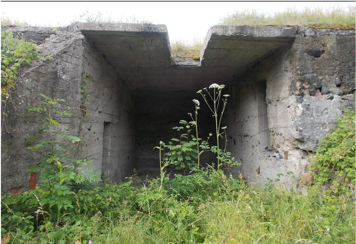
Foto 36. Luure- ja sihtmärgiosutusjaama P-18 (1RL-131) betoonpunker e kaponiir [104]. Koosneb kolmest tehnikaboksist ja nende kõrvale (pildil vasakul) ehitatud varjendist. Laes on nelinurkne ava antennimasti jaoks, mis oli paigutatud veoauto Ural šassiile.
