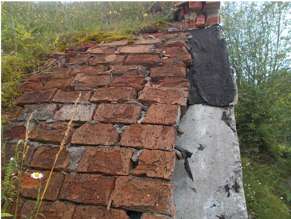
Foto 6. Vaade hoidla katuse hüdroisolatsiooni telliskattele kirdest.
