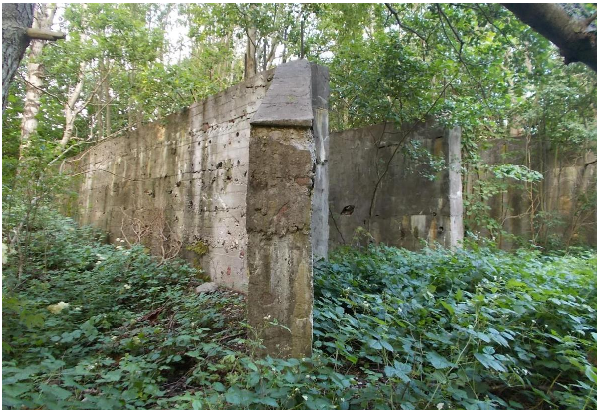
Foto 29. Rühmavarje [77]. Katus puudub, jälgi selle olemasolust ei leidnud. Divisjoni kolmest rühmavarjest oli see ainus, mis oli betoonseintega, kapitaalselt välja ehitatud.
