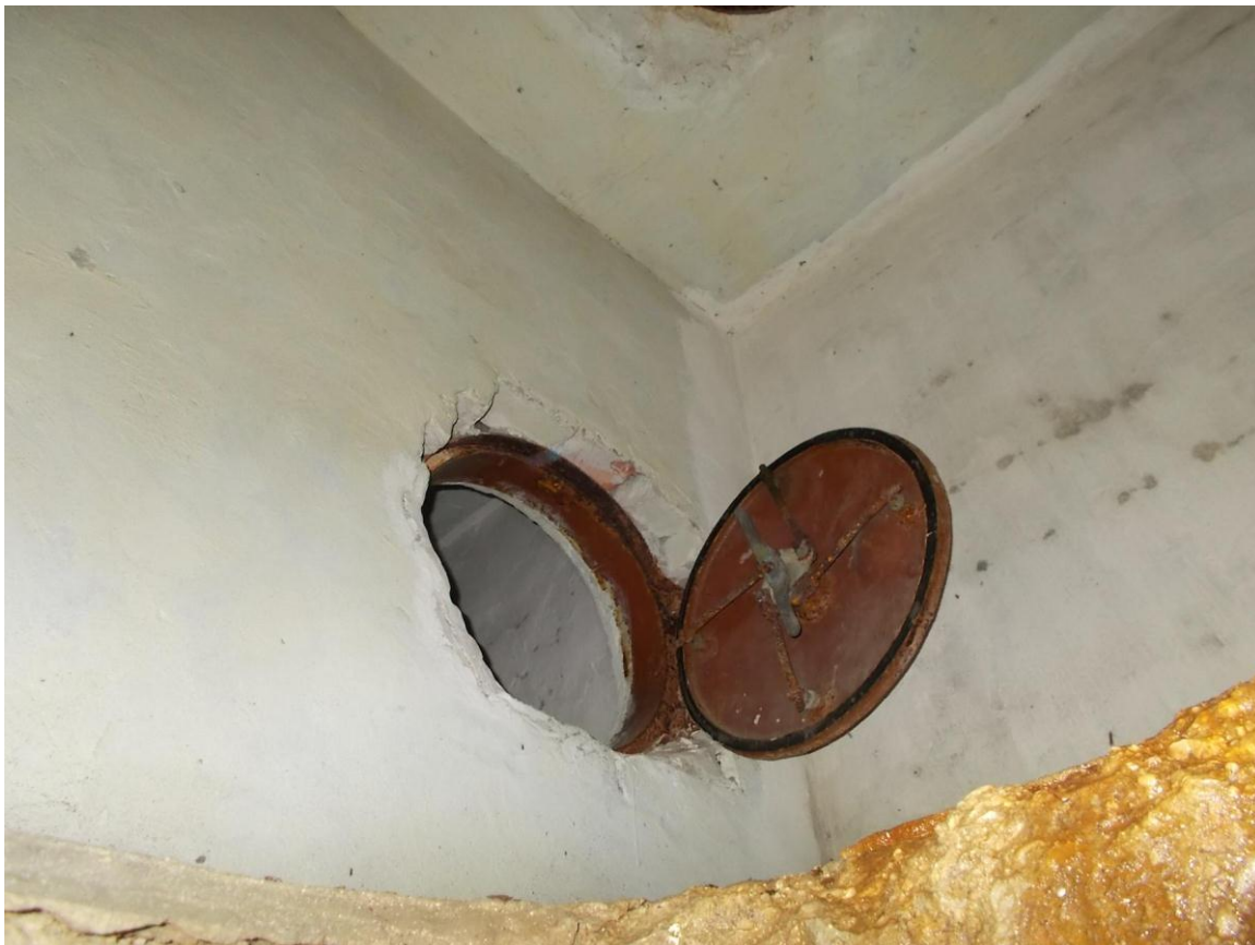
Foto 14. Hoidla [62] kliimabloki ventilatsiooniruumil on madal teine korrus kahe väikese ruumiga, millest üks on suletav hermeetilise luugiga.
