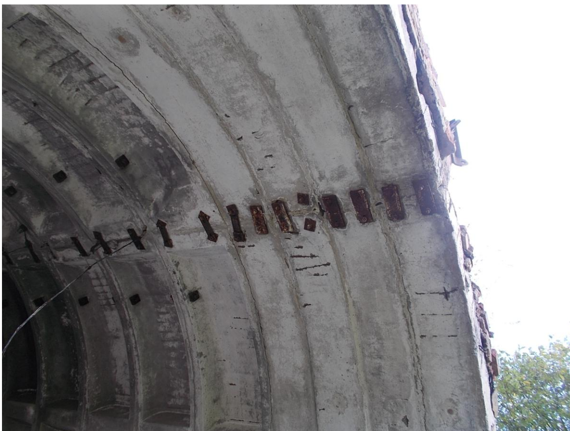
Foto 7. Vaade altpoolt varje kaarte ühenduskohale. Eespool kitsamad kaarelemendid EA-2T ja EA-2, tagapool 1 m laiused EA-1.
