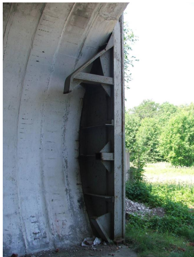
Foto 3. Tuumaraketihoidla [62] 2005. aastal. Ukseraam/soomusplaat — vaade seestpoolt. Foto Marko Sula.
