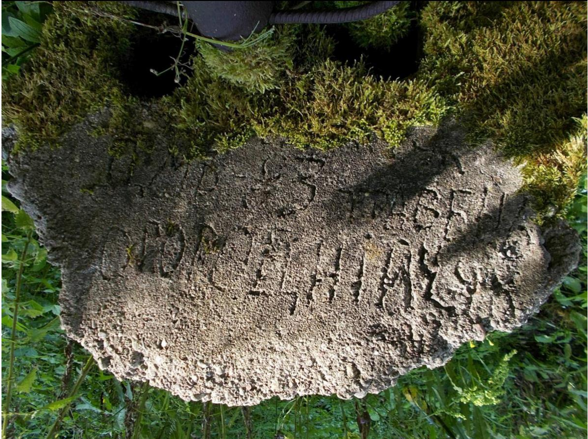
Foto 30. 1. laskeseadme positsioon (numeratsioon vastavalt skeemile 10–11) [79]. Maskeerimisvõrgu? posti betoonalusesse on valamisel jäädvustatud ukraina keeles: „DMB-83 sügis Ogorodniitšuk”. Laskeseadmeõued ei kujutanud endast üksnes pinnasevalle, vaid keerukat kompleksi: betoneeritud posti- jm aluseid, kaablikanaleid, drenaažisüsteeme jm; Maantee divisjonis on mitme laskeseadme asukoha ümber valatud ka betoonkõnniteed. Betooni on sageli jäädvustatud nimesid, aastaarve ja muud nüüd juba ajaloolist infot.
