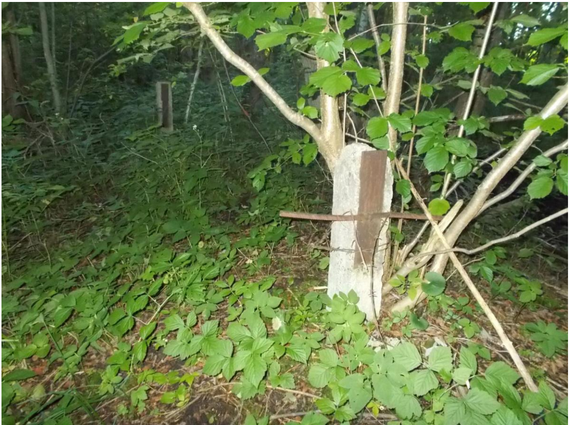
Foto 21. Tuumarelvahoidla soojatrassi alused [58], suunduvad punktist [59] läbi metsa katlamajani [49].
