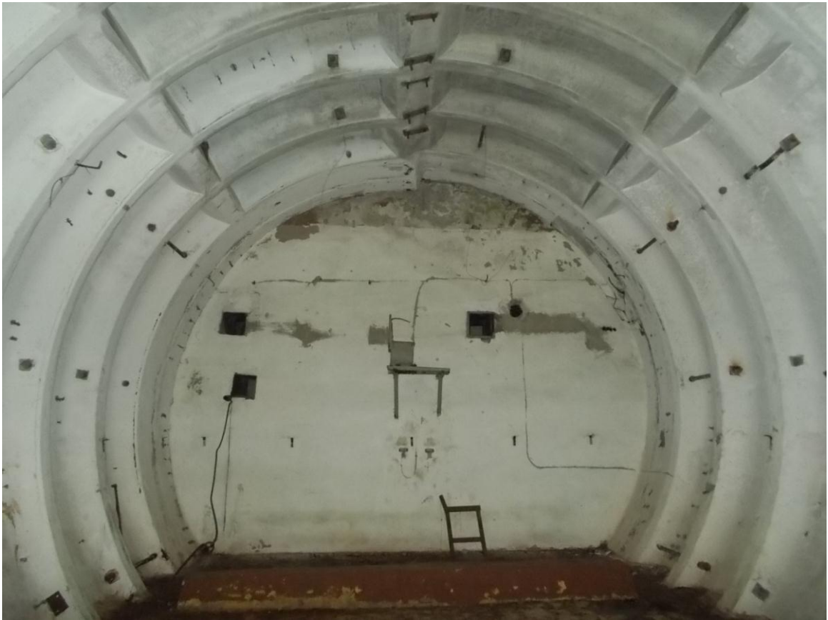
Foto 10. Kaarvarje tagasein, all betoonist rattapiire.
