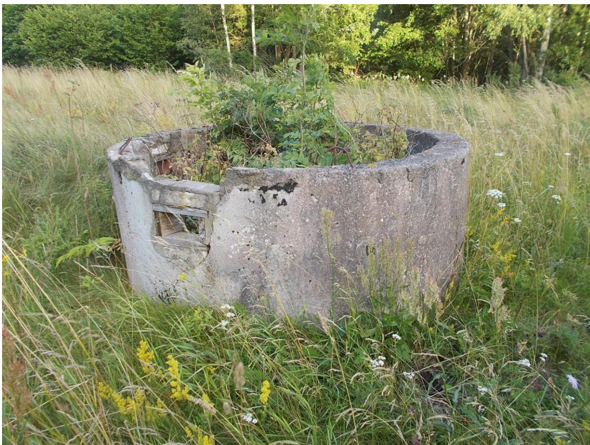
Foto 23. Tuumarelvahoidla doti [61] ülaosa, milles on kolm laskeava. Vaade põhjast. Vastavalt skeemile 10–11 oli hoidla ümber neli doti: kolm väljaspool välimist aeda ja üks keskmise ning välimise aia vahel (kahe välimise aia vahel oli ka kolm kaevikut).
