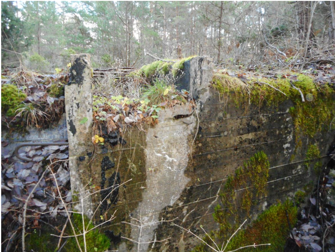
Foto 8. Suurtükibloki nr 1 läänepoolne betoonist kommunikatsioonikanal. Foto Jüri Pärn 6.12.2017.
