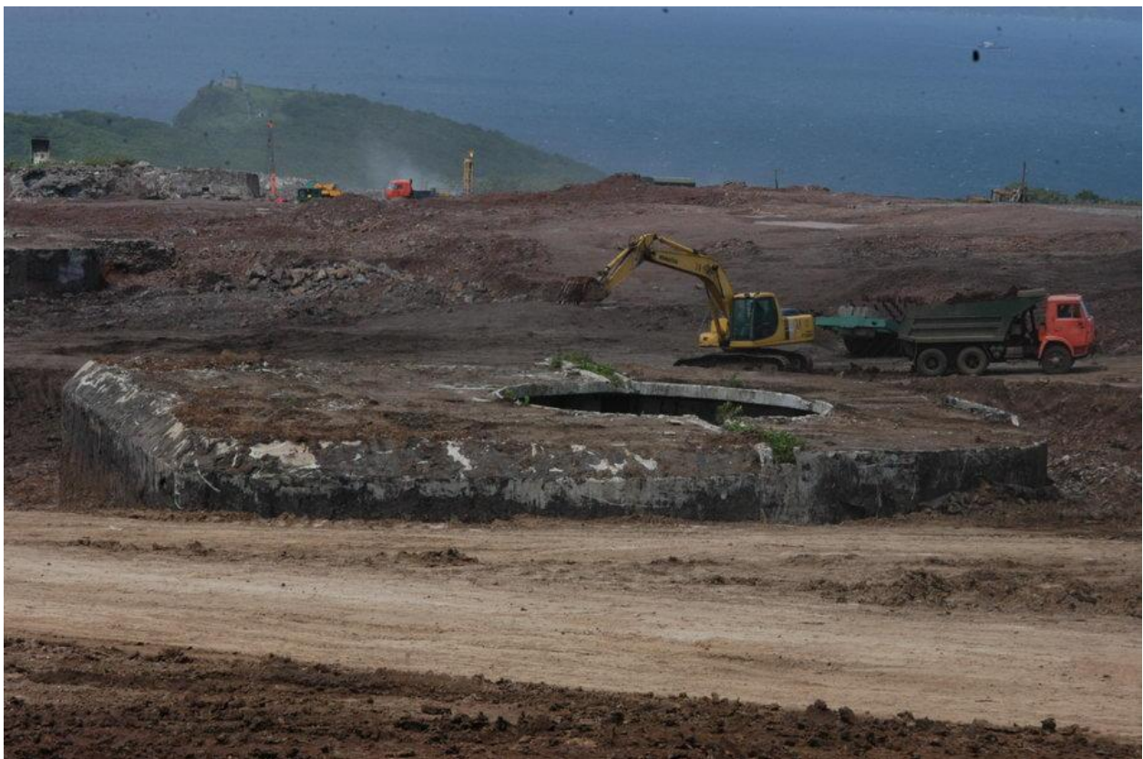
Foto 21. Aga sellised oleksid Ninase patarei suurtükiblokid väljakaevatutena. Ninase patareiga analoogiline 180 mm-se avatud patarei ehitised Venemaal Nahhodka sadama lähedal 2008. aastal, enne lammutamist ( http://digger-club.ucoz.ru/forum/3-28-1 ). Paremal sissepääsuga tagakülg, vasakul laskemoonaruumid.
