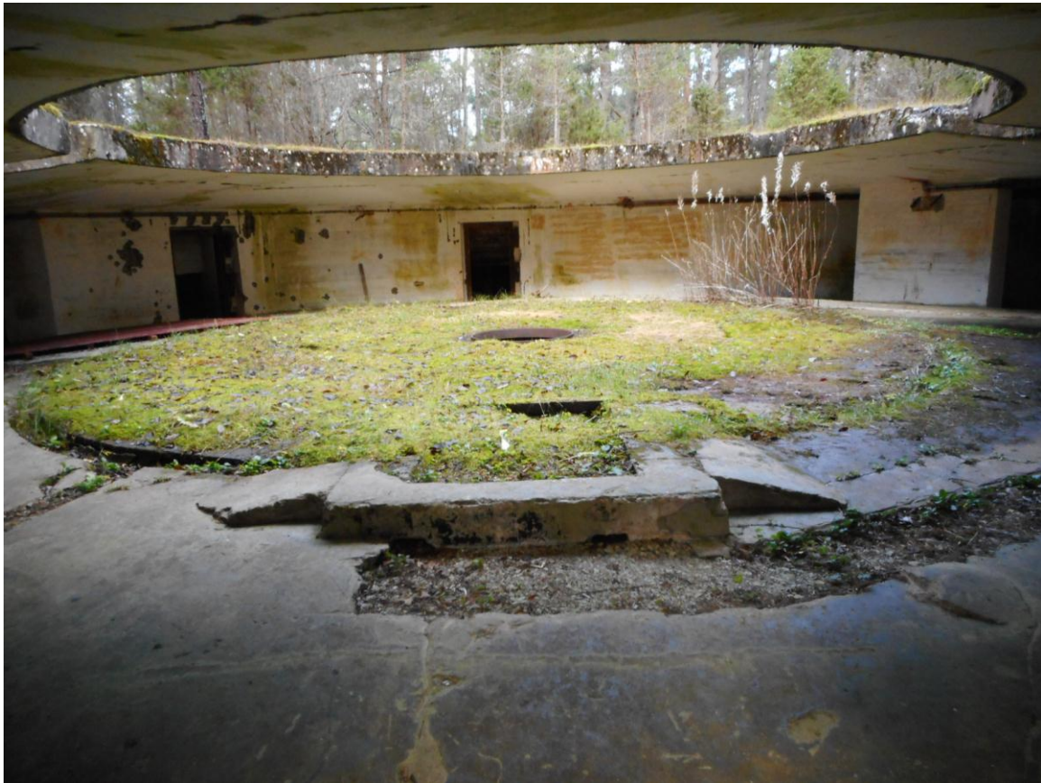
Foto 10. Suurtükibloki nr 1 sisevaade. Esiplaanil täisaetud sissepääs suurtükitumba alusesse ruumi. Foto Jüri Pärn 6.12.2017.
