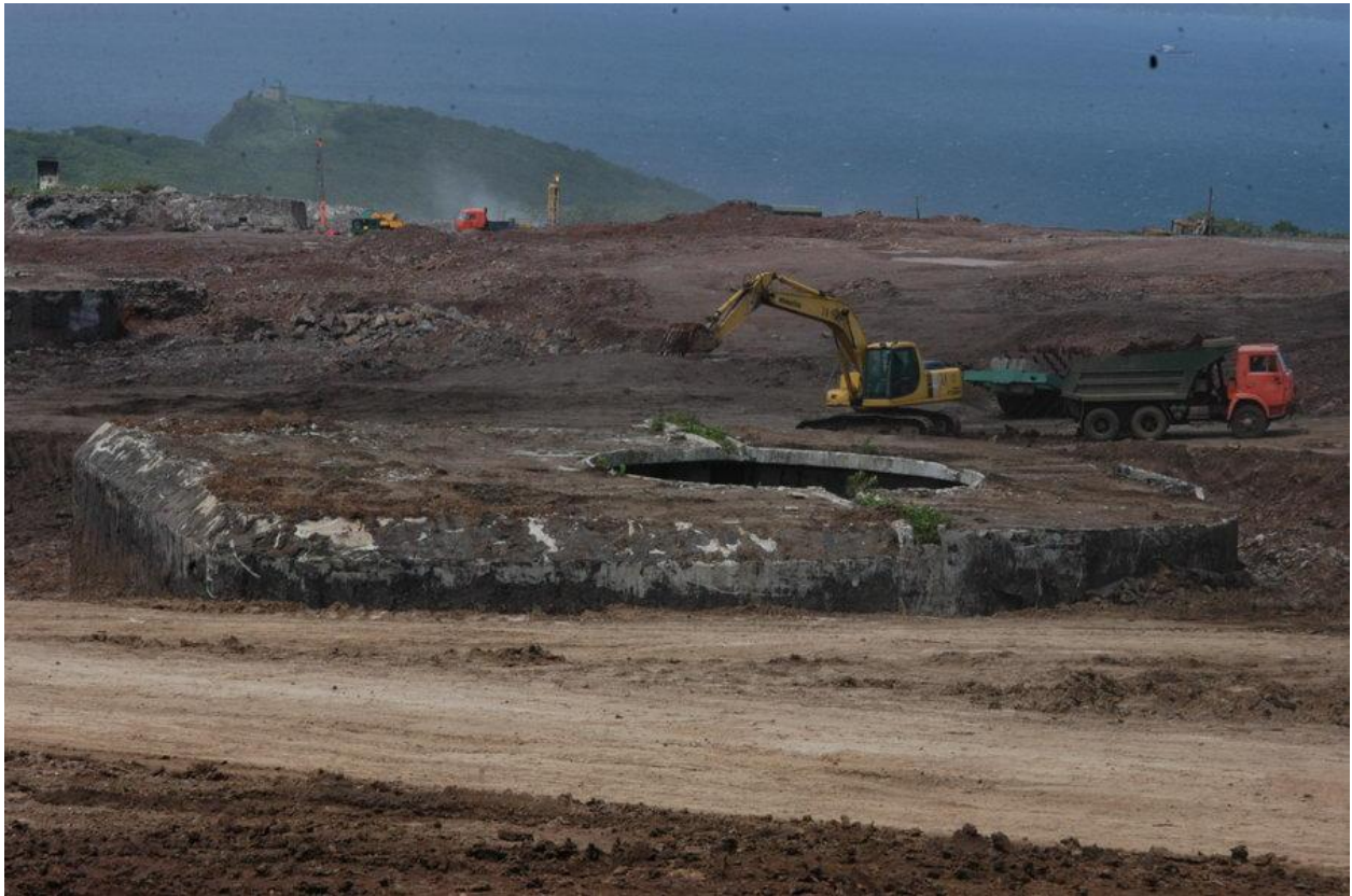
Foto 21. Ninase patareiga analoogiline 180 mm-ne avatud patarei suurtükiblokk Venemaal Nahhodka sadama lähedal 2008. aastal, enne lammutamist väljakaevatuna ( http://digger-club.ucoz.ru/forum/3-28-1 ). Paremalt sissepääsuga tagakülg.
