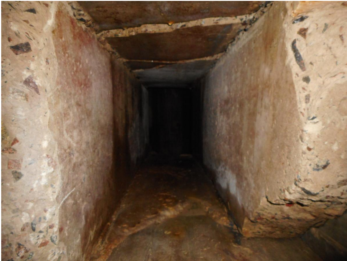
Foto 23. Ninase suurtükiblokk nr 3. Mürsuelevaatori kanali sisevaade. Foto Jüri Pärn 6.12.2017.
