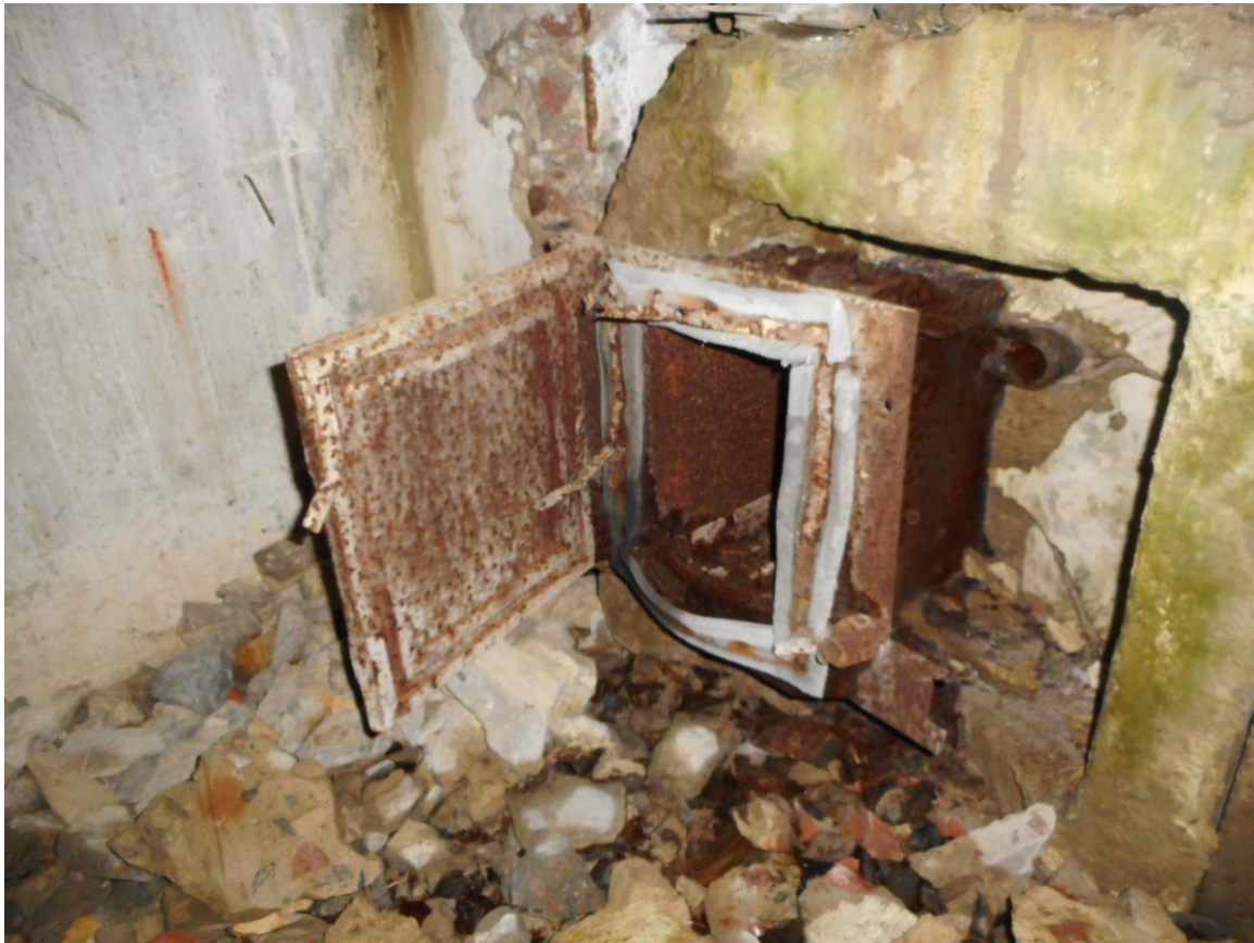
Foto 27. Ninase suurtükiblokk nr 3. Laenguedastusluuk. Foto Jüri Pärn 6.12.2017.
