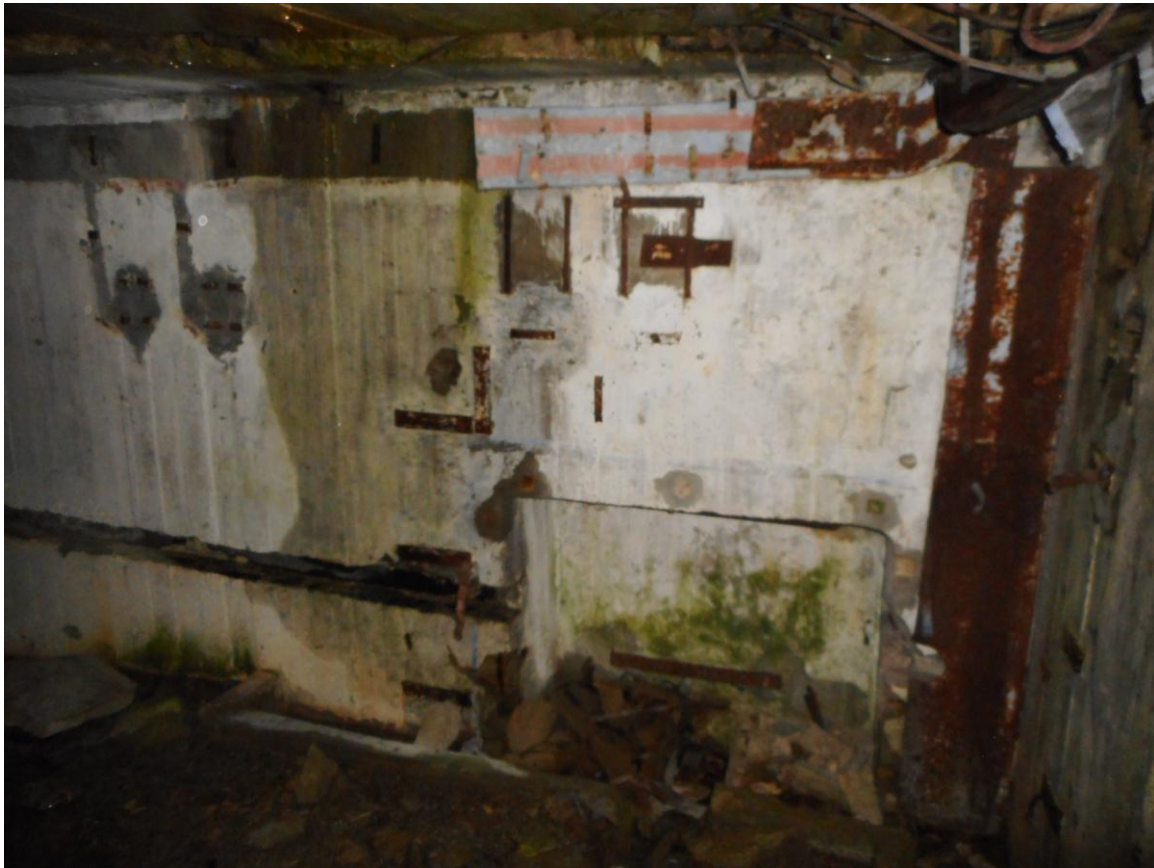
Foto 25. Ninase suurtükiblokk nr 3. Foto Jüri Pärn 6.12.2017. Seadmekandurid mürsuelevaatori esise niši seinal.
