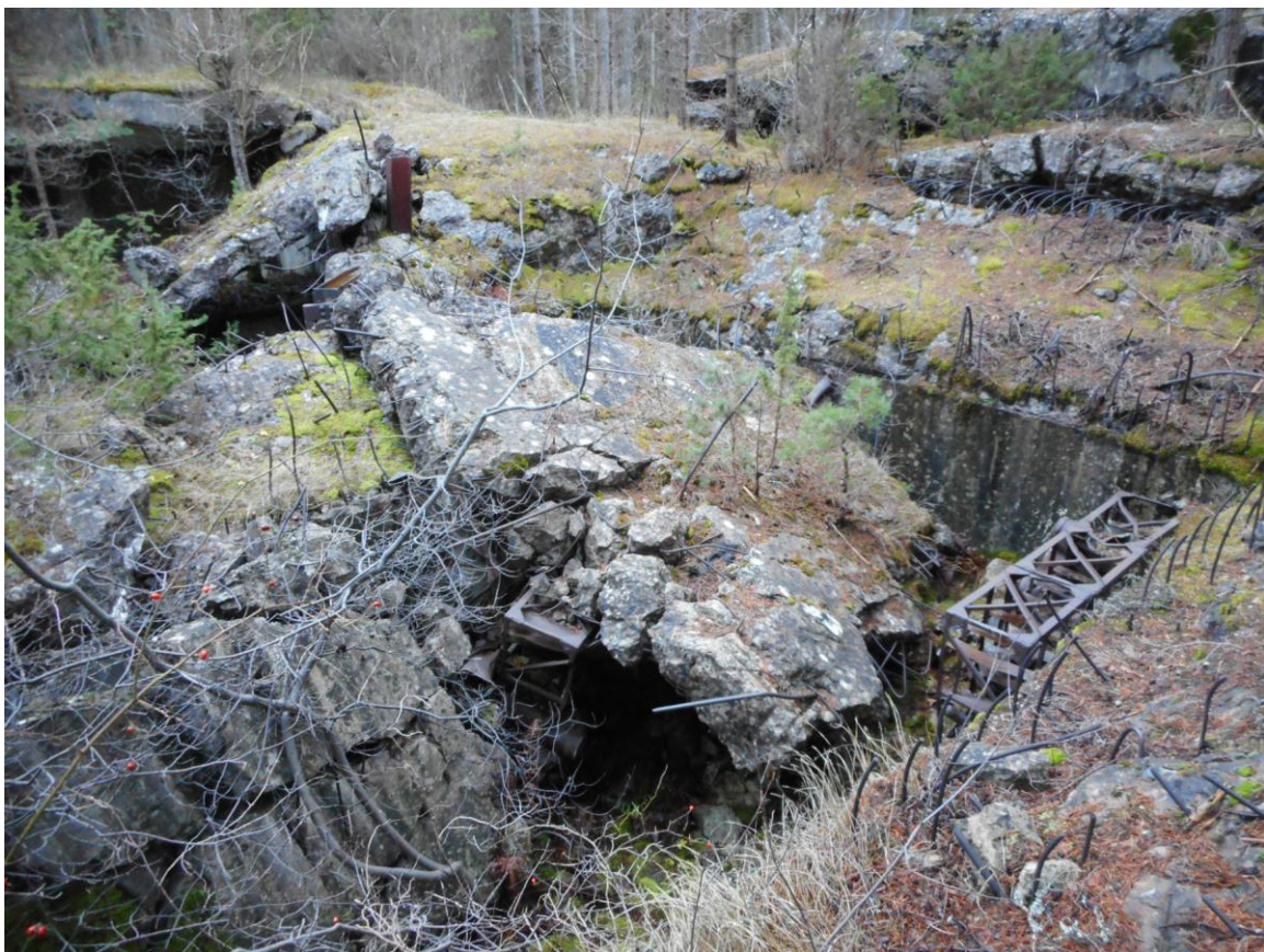
Foto 6. Ninase suurtükiblokk nr 3. Vaade laenguhoidlale. Paremäl ülanurgas on äralennanud katus, mille asemele on „antud” tükike märksa õhemat varikatust. Foto Jüri Pärn 6.12.2017.
