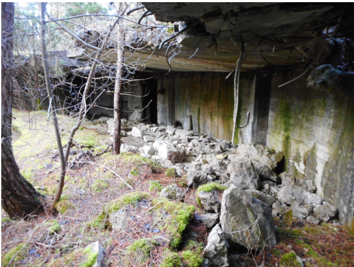
Foto 18. Ninase suurtükiblokk nr 3. Sisevaade varikatuse alt (kirdesse). Foto Jüri Pärn 6.12.2017.
