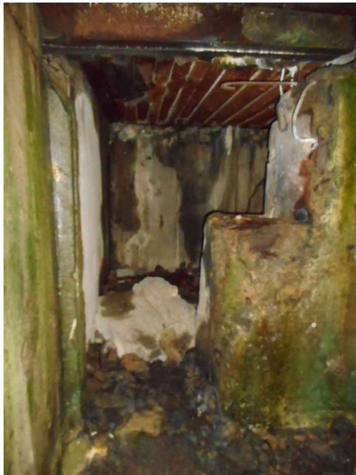
Foto 21. Ninase suurtükiblokk nr 3. Mürsuhoidla ukseava koos mürsuedastusavaga, lähemalt. Foto Jüri Pärn 6.12.2017.
