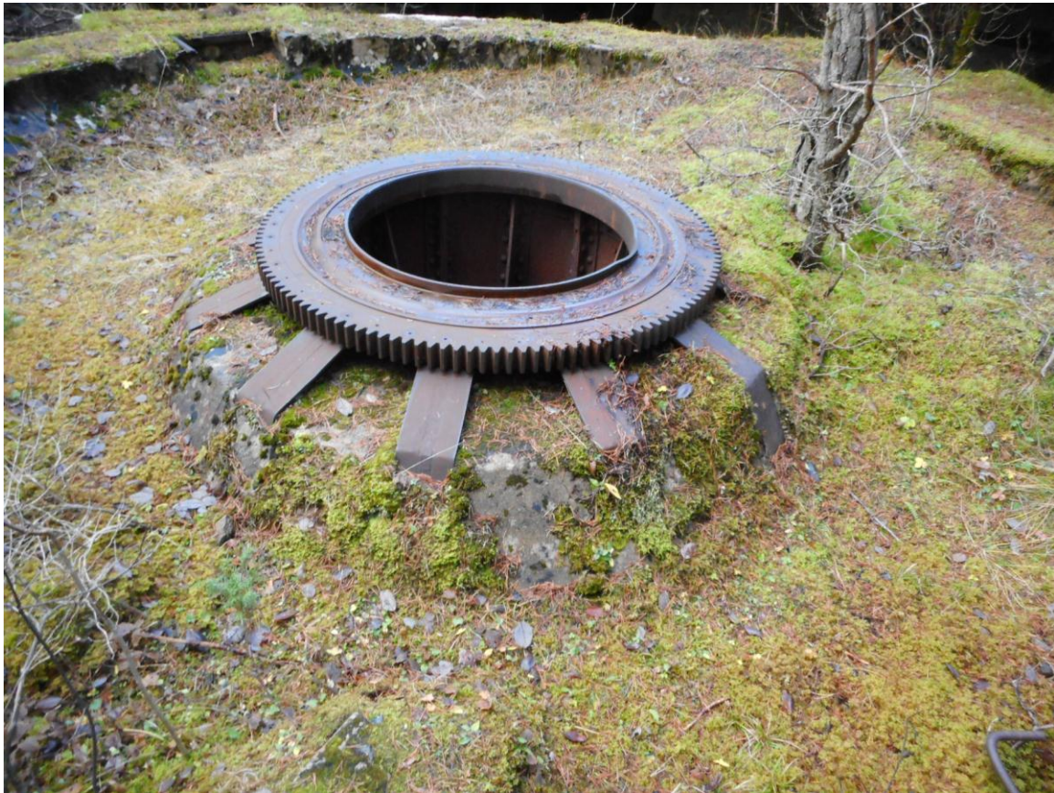
Foto 13. Ninase suurtükiblokk nr 3. Suurtükialus. Tumba betooni valatud „jalgadeks” on painutatud I-talad. Foto Jüri Pärn 6.12.2017.
