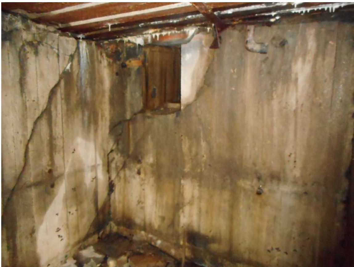
Foto 22. Ninase suurtükiblokk nr 3. Mürsuedastusruum elevaatori avaga. Foto Jüri Pärn 6.12.2017.
