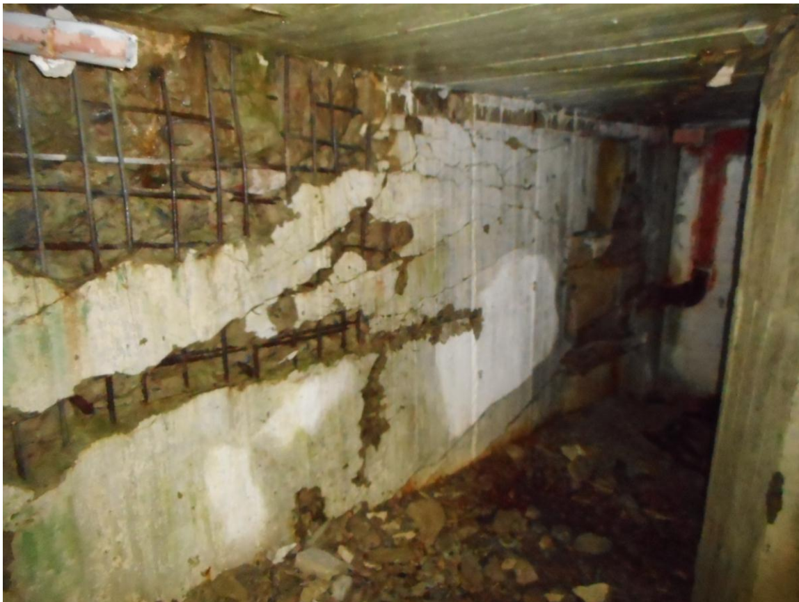
Foto 19. Ninase suurtükiblokk nr 3. Mürsuruumide suurtükiõue poolne sein, mille paksus on üle 2 m. Foto Jüri Pärn 6.12.2017.
