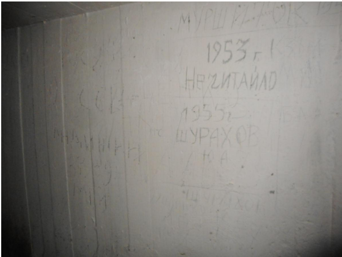
Foto 30. Ninase suurtükiblokk nr 3. Autograafid seinal. Foto Jüri Pärn 6.12.2017.
