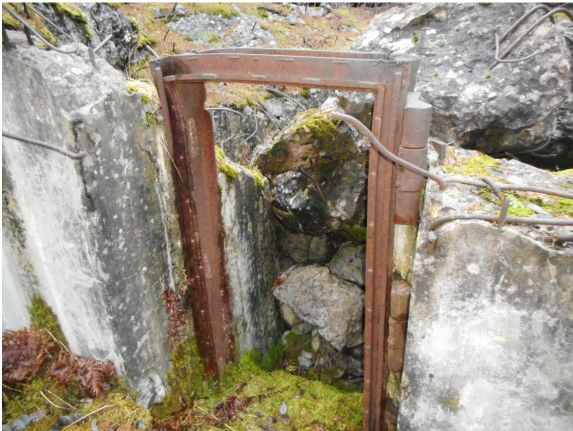
Foto 26. Ninase suurtükiblokk nr 3. Laenguedastusruumi metallist uksepiit. Foto Jüri Pärn 6.12.2017.
