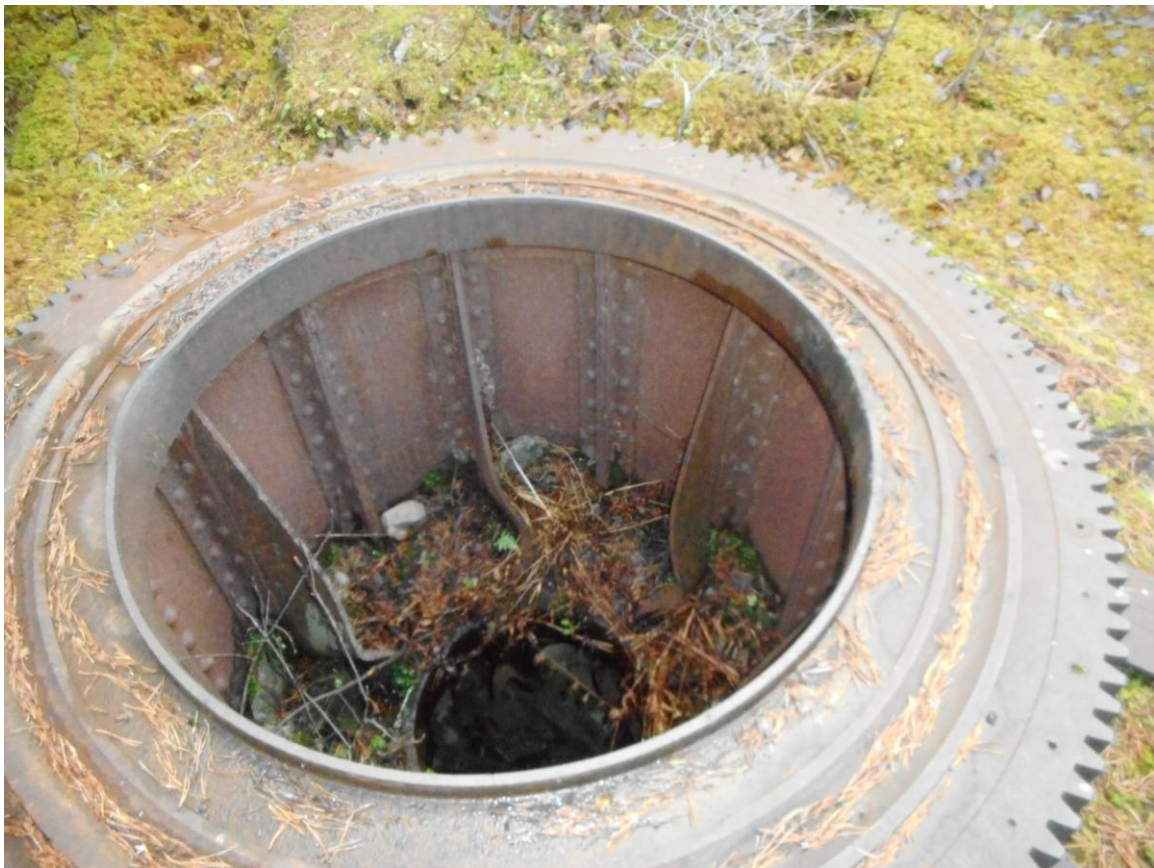
Foto 14. Ninase suurtükiblokk nr 3. Suurtükitumba jahutusribidega. Allpool põhjas nähtavat tsentriava on samasugused ribad. Foto Jüri Pärn 6.12.2017.
