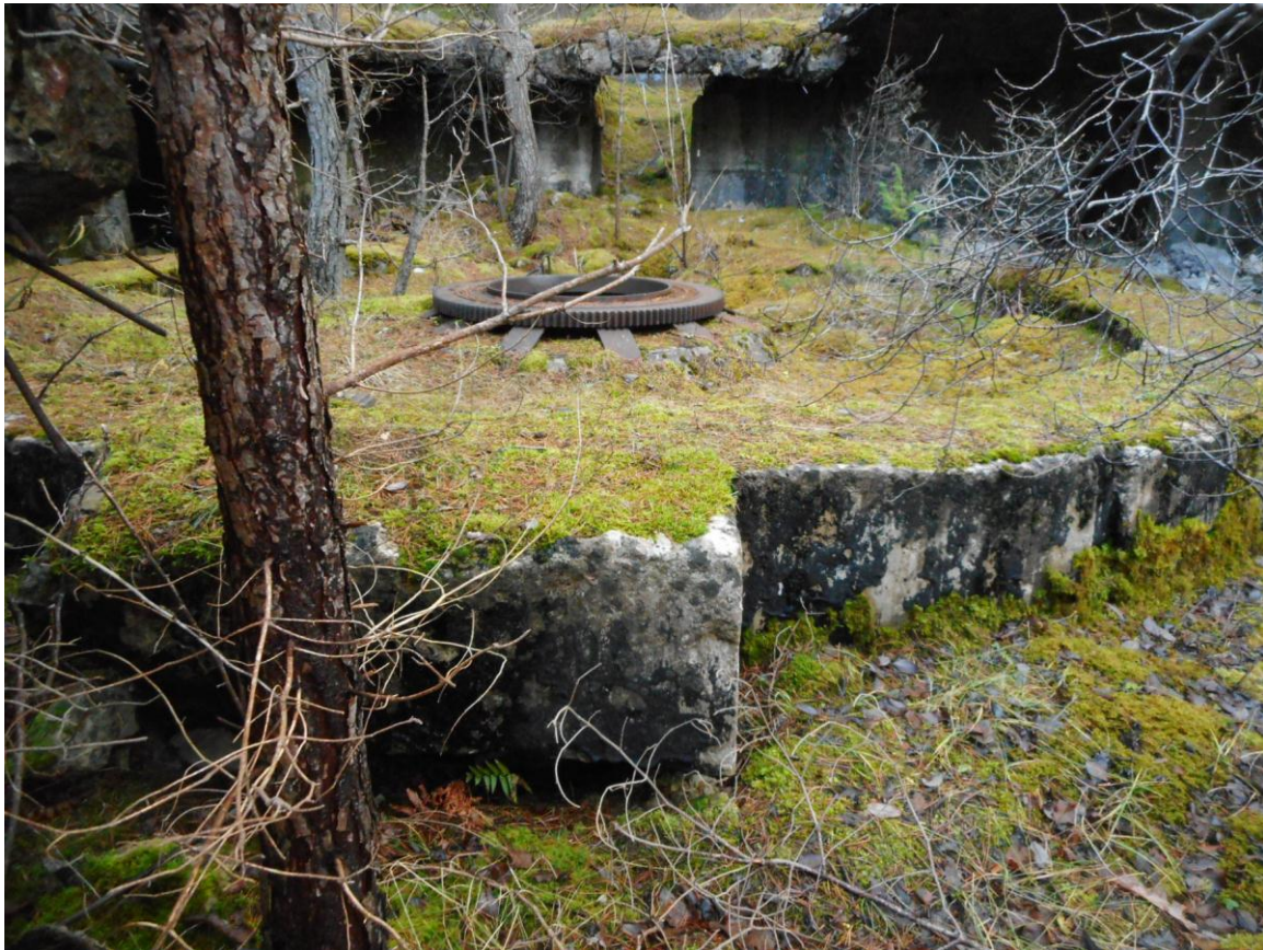
Foto 15. Ninase suurtükiblokk nr 3. Suurtükialus. Erinevalt teistest patarei kahurialustest on selle betoonümbris äärtest lahtine – kas pooleli jäänud või plahvatuse poolt „puhastatud” (üles kergitatud?). Foto Jüri Pärn 6.12.2017.
