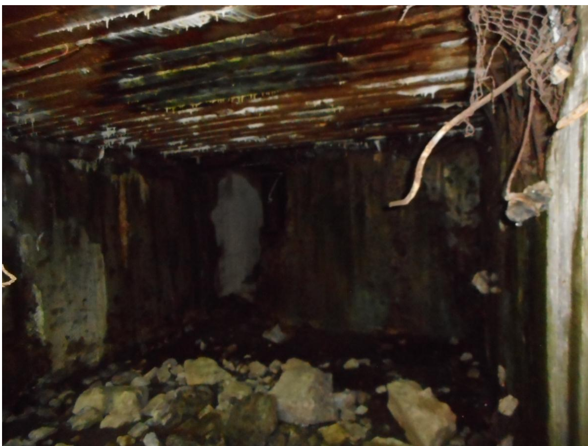
Foto 20. Ninase suurtükiblokk nr 3. Mürsuhoidla. Taga vasakul nurgas ukseava koos mürsuedastusavaga. Foto Jüri Pärn 6.12.2017.
