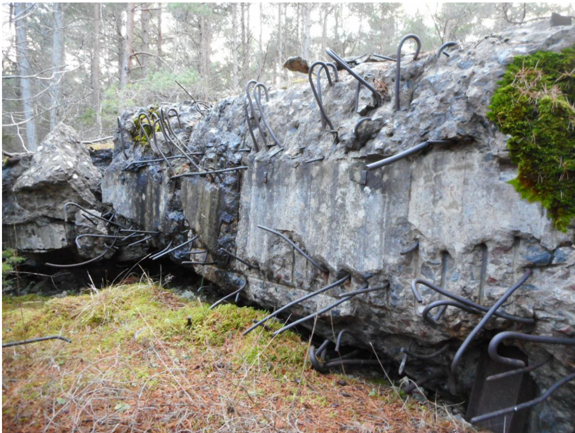
Foto 10. Ninase suurtükiblokk nr 3. Bloki kõrvale (läände) tõstetud laenguruumide katus. Vaade edelast. Foto Jüri Pärn 6.12.2017.
