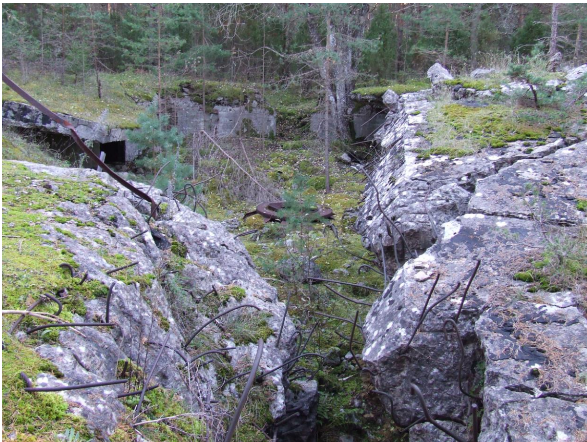
Foto 4. Positsiooni nr 4 lae faasitud loodepoolne välisserv on plahvatuse tulemusena pööratud sissepoole (pildi keskel paistab suurtükialuse hammasring). Foto Mart Mõniste 20.10.2007.
