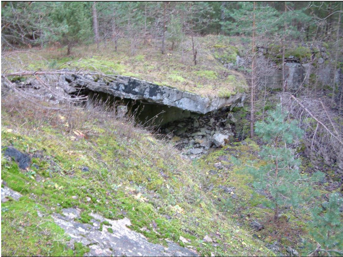
Foto 3. Positsiooni nr. 4 purustatud betoonlagi. 2006. Allikas: Saare maakonna militaarobjektide ekspertiis. Koostaja: Endel Püüa.
