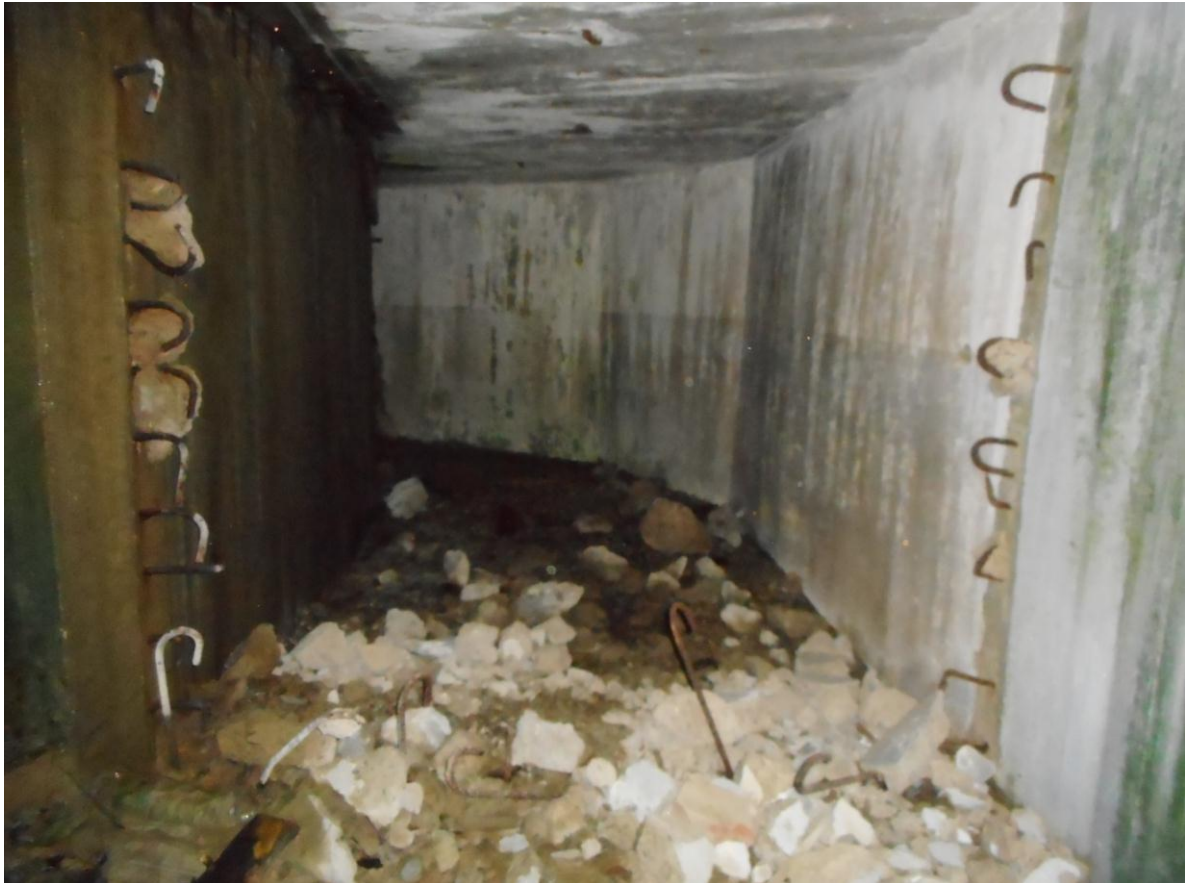
Foto 12. Suurtükibloki nr 4 lõhutud vahesein läänepoolsetes külgruumides. Foto Jüri Pärn 6.12.2017.
