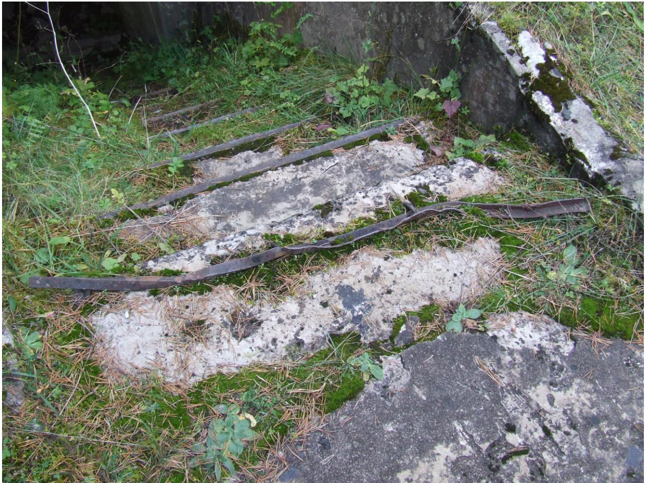
Foto 15. Jõujaama sissepääsutrepp. Foto Mart Mõniste 20.10.2007.
