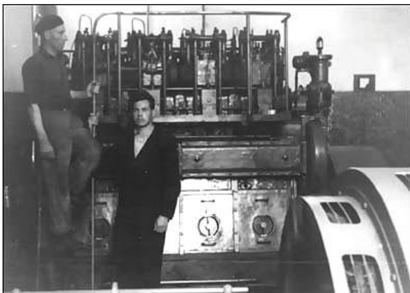
Дизельный агрегат «Двигатель революции» №12 на электростанции города Кярдла, остров Хийумаа. На переднем плане генератор «Электросила». Фото с сайта www.mil.hiiumaa.ee
