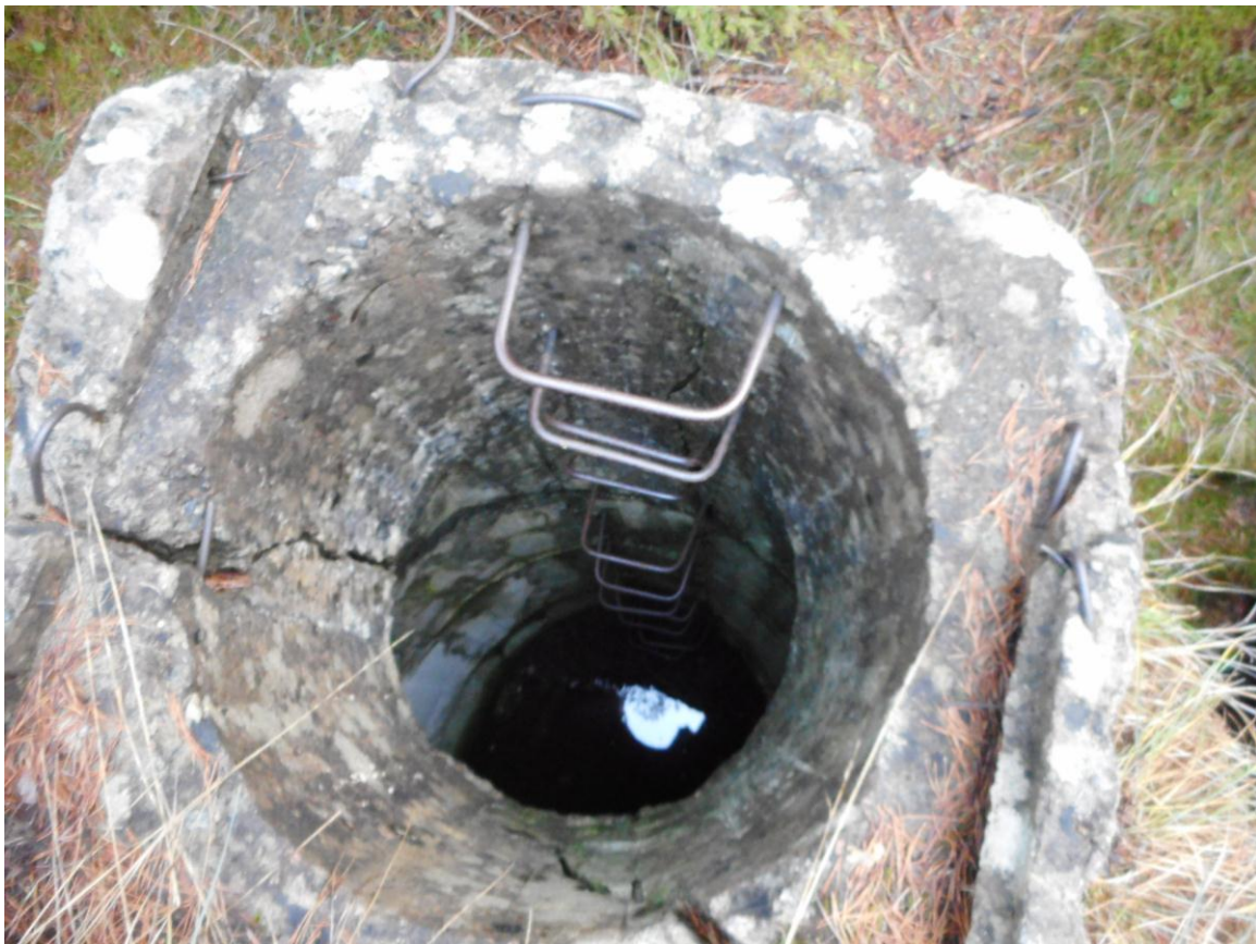
Foto 8. Jõujaama varuväljapääsu? šaht 2017.a hilissügisel. Seekord on põhi veega kaetud. Foto Jüri Pärn 6.12.2017.
