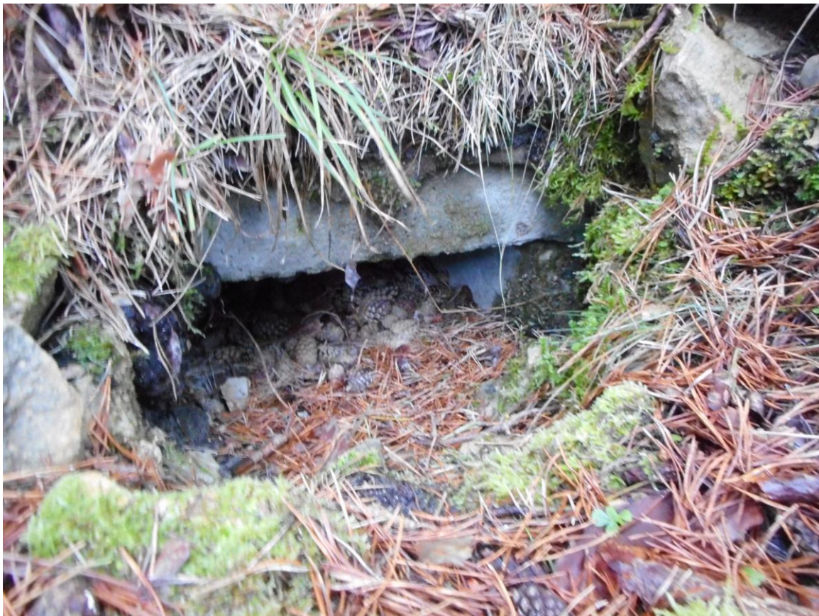
Foto 12. Betoneeritud soojatrassi kanal jõujaamast kagus. Foto Jüri Pärn 6.12.2017.
