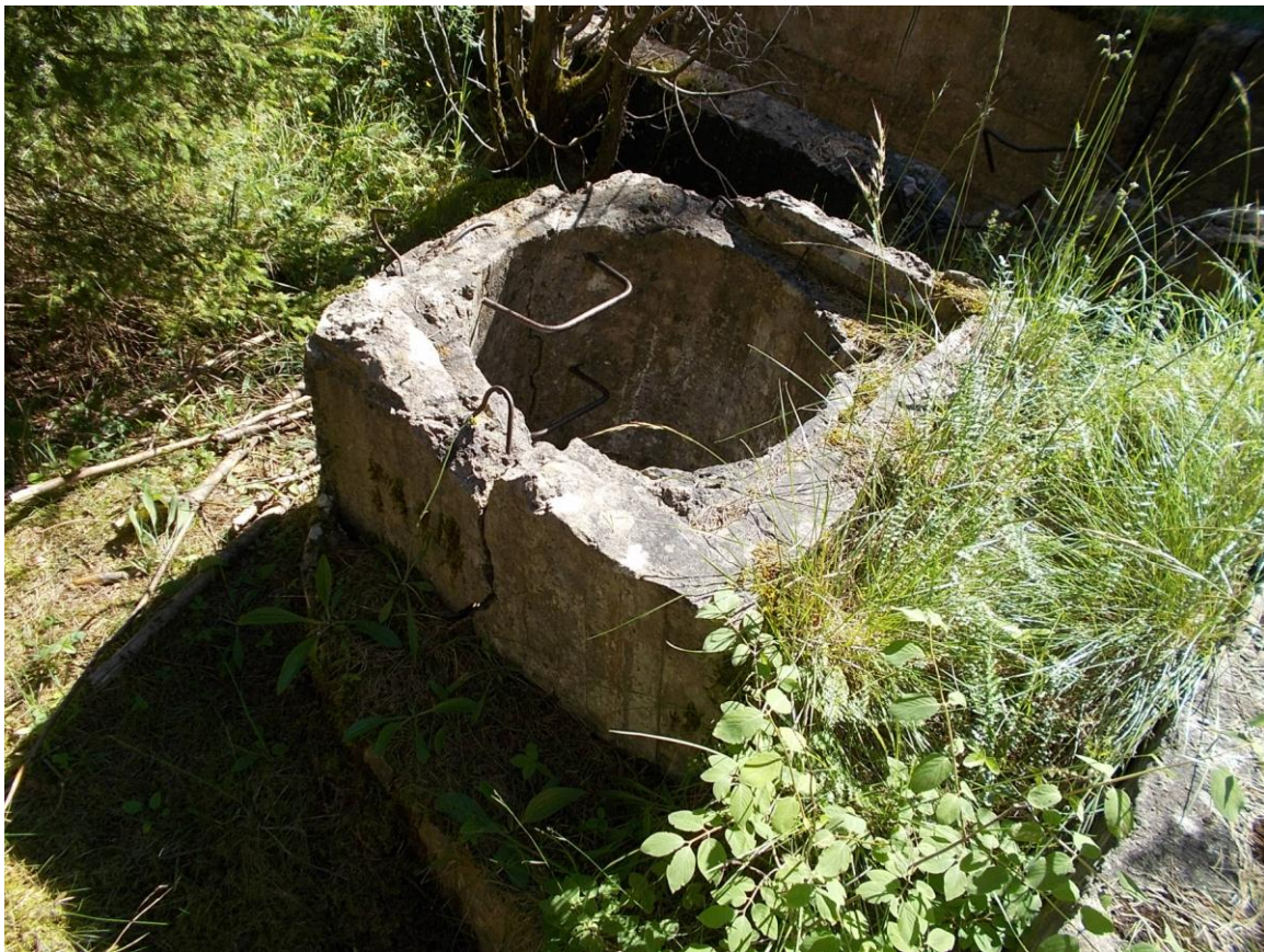
Foto 6. Jõujaama varuväljapääsu? šaht riisktrapiga. Foto Jüri Pärn 28.06.2015.
