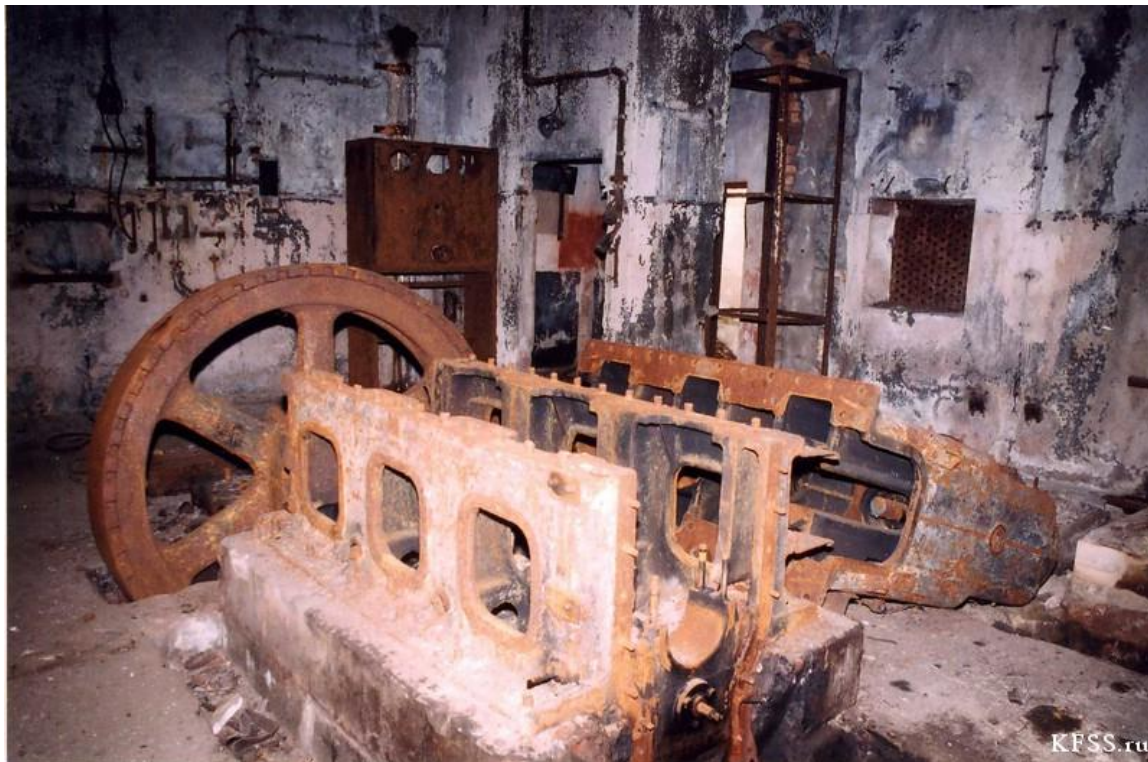
Foto 29. Nahhodka 180 mm avatud patarei nr 10 jõujaama (mehaanikabloki) diiselagregaat 2005.a ( http://kfss.ru/index.php/objekts/261-b110 ). 3-silindriline ja teist tüüpi kui Ninase oma.
