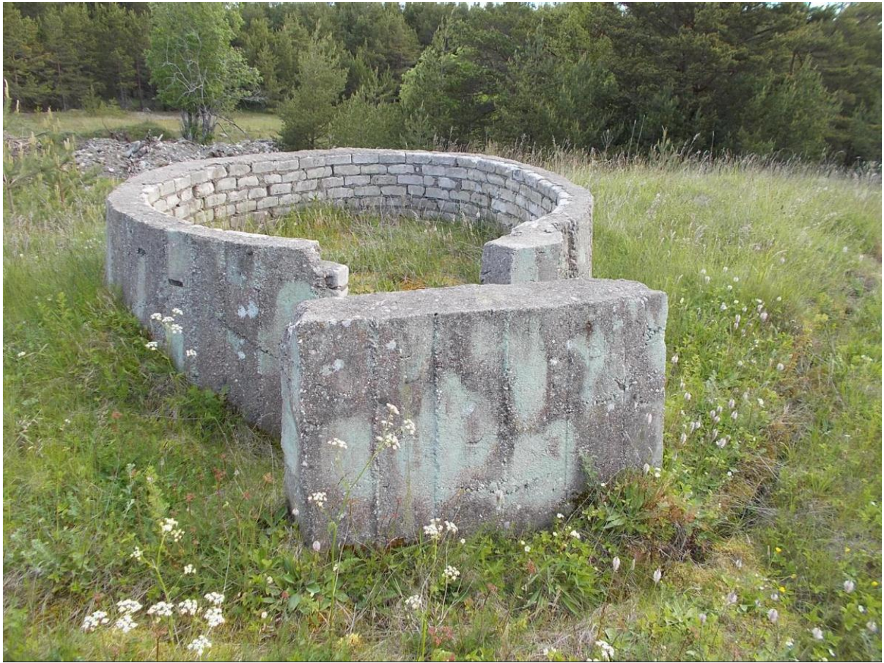
Foto 34. Tagaranna seniitraketidivisjon. Komandopunkti [66] visuaalvaatluspost. Siseseinale on kantud kraadiväärtused asimuudi määramiseks. Foto Jüri Pärn 10.06.2015.
