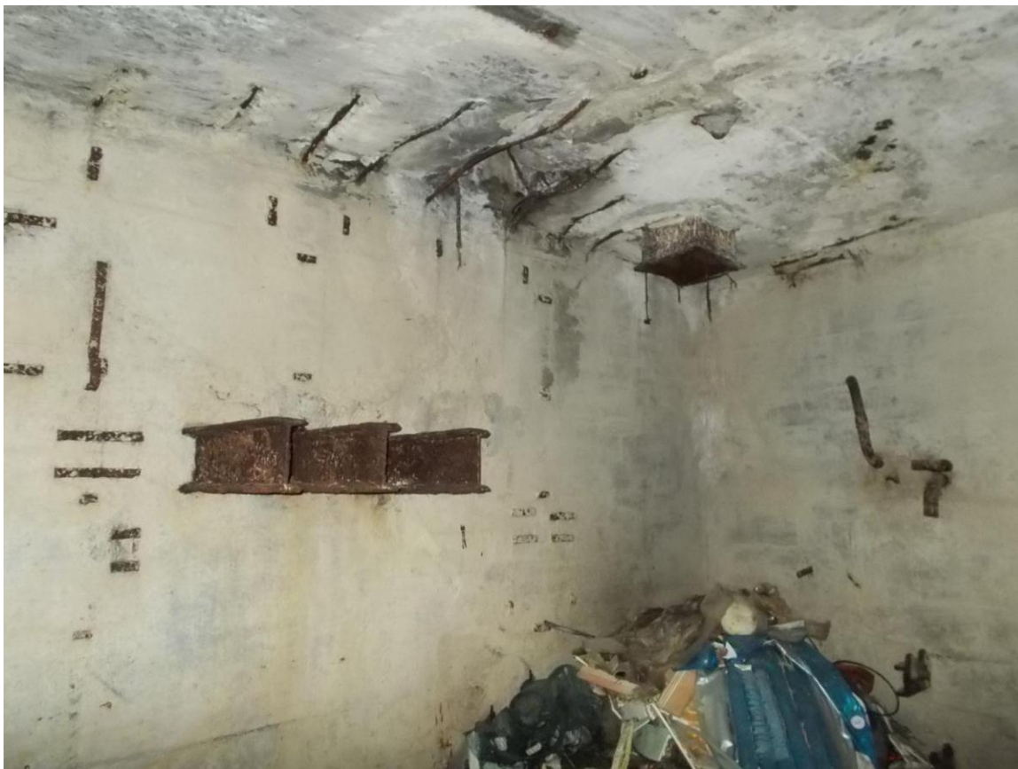
Foto 53. Ninase 180 mm rannapatarei. Punker (katlamaja?) [40] seestpoolt. Seinast väljuvad kaks toru komandoposti [65] suunas. Enamus põrandast on kaetud prahiga — keegi on vaevunud oma sodi kahest õhuavast sisse toppima. Divisjon kasutas juurviljakeldrina (läheduses asunud sigala jaoks?). Foto Jüri Pärn 27.06.2015.
