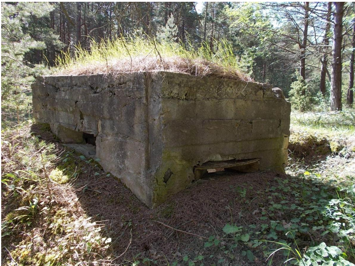
Foto 71. Betoonist valatud trapetsikujuline dott [71]. Foto Jüri Pärn 10.06.2015.
