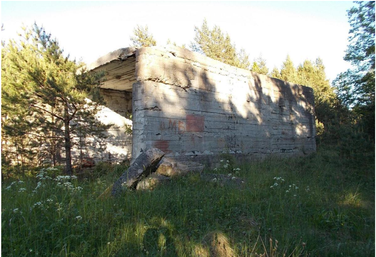
Foto 66. Juhtimisrühma kabiinide betoonkaponiir [30], vaade läänest. Foto Jüri Pärn 10.06.2015.
