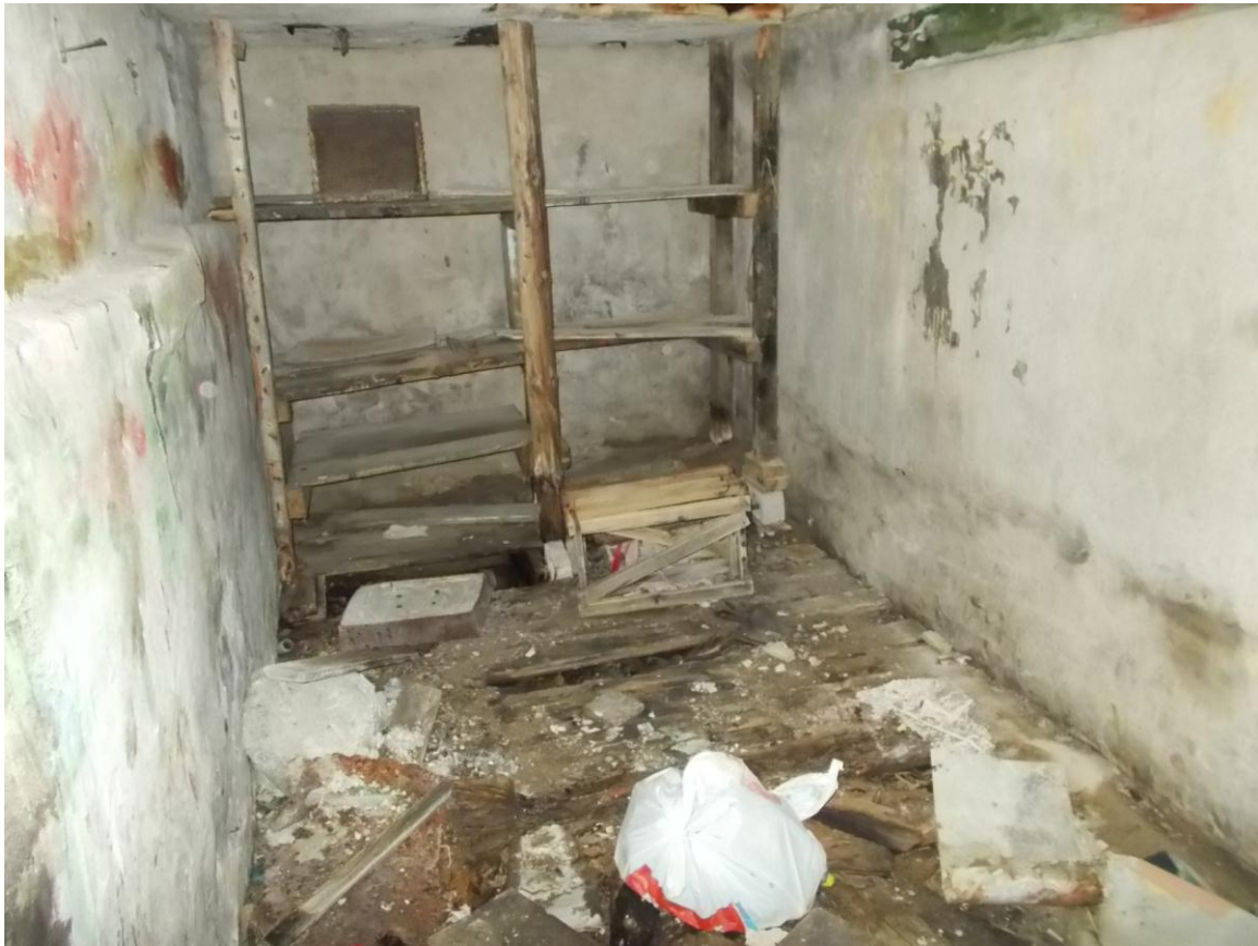
Foto 47. Komandopunkti [66] 2-korruselise juurdeehituse lõunapoolne ruum. Riuli ees laes luugiava II korrusele. Foto Jüri Pärn 10.06.2015.
