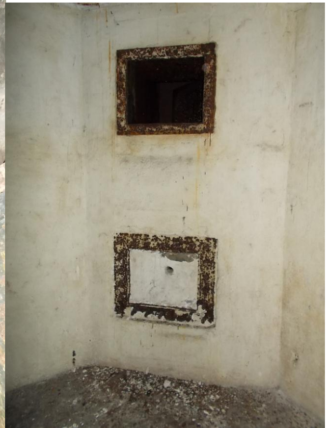
Foto 15. Komandoposti [65] masinaruumi lõõr. Alumine ava kinni müüritud, ülemises terasluuk. Foto Jüri Pärn 10.06.2015.
