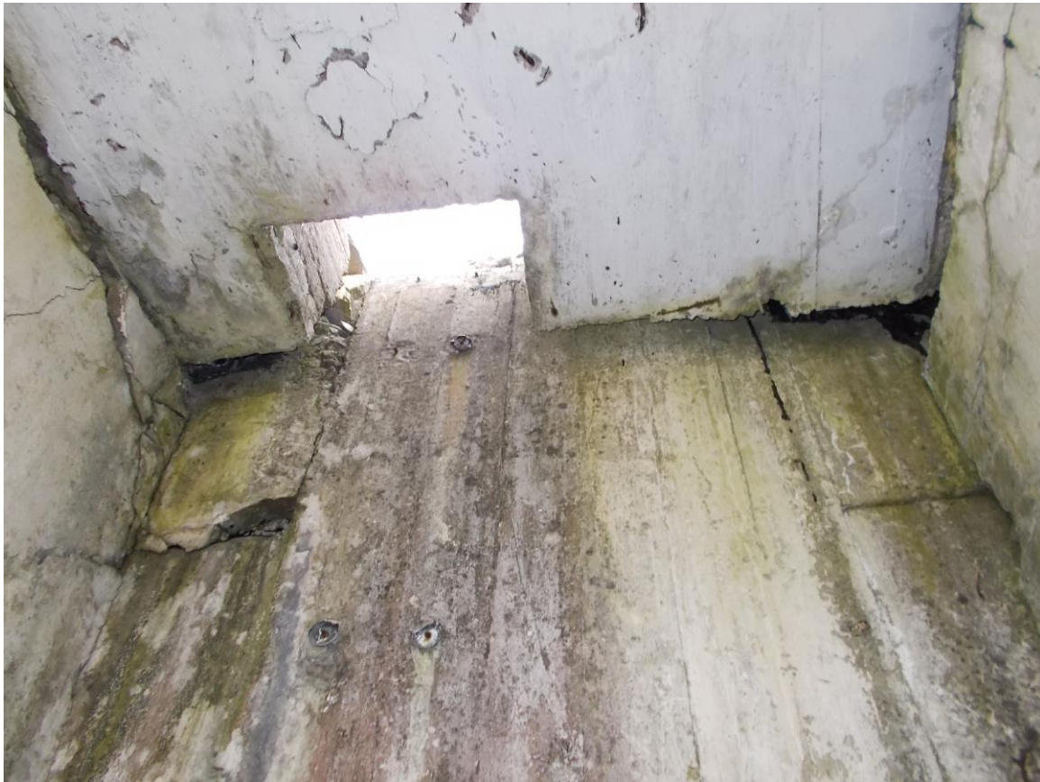
Foto 9. Luugiava KP [65] läänepoolse sissepääsu kohal. Seinas on alumiiniumümbristega poldipaarid (redeli või juhtmekanduri jaoks?). Foto Jüri Pärn 10.06.2015.
