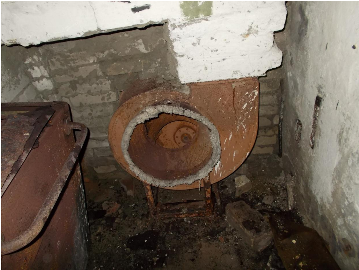
Foto 26. Komandoposti [65] ventilaatoriga ruum, sissepääsulüüsi kõrval. Foto Jüri Pärn 10.06.2015.
