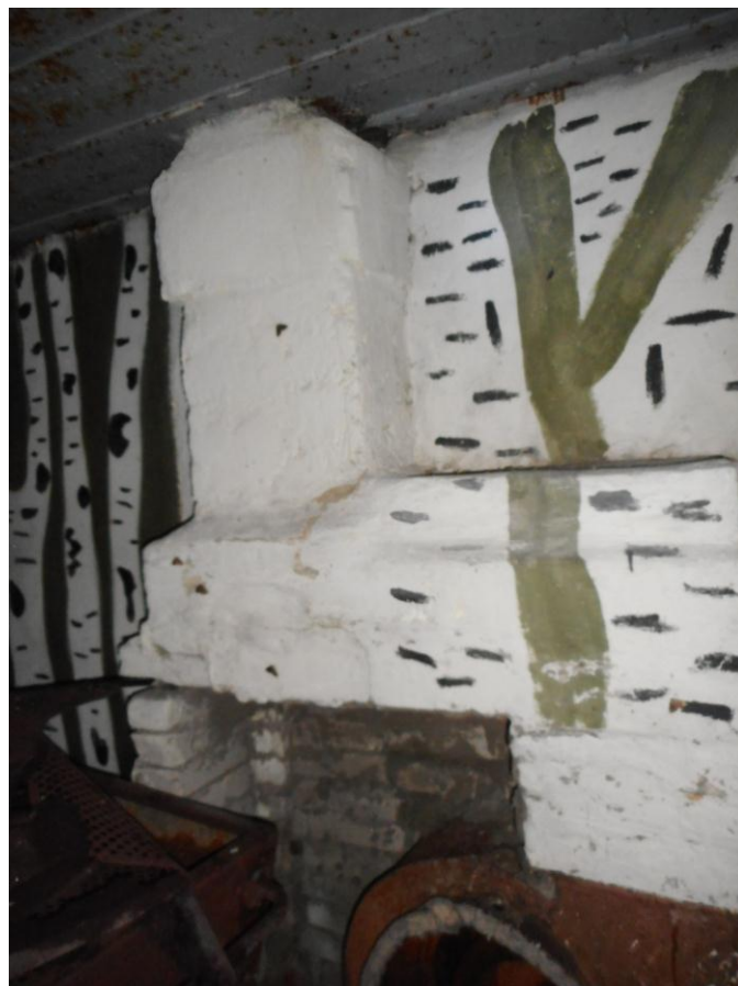
Foto 27. Komandoposti [65] ventilaatoriga ruum, sissepääsulüüsi kõrval. Foto Jüri Pärn 6.12.2017.
