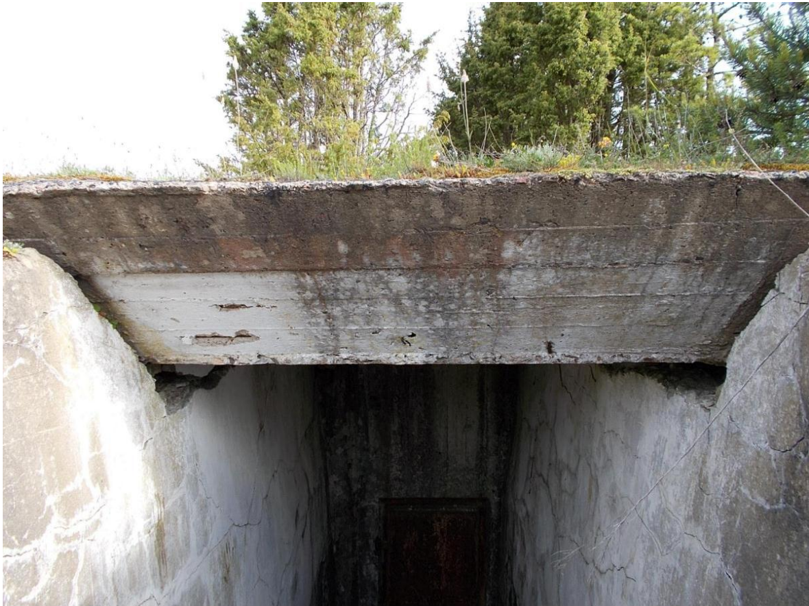
Foto 7. Komandoposti [65] sissepääse katab üle 0,5 m paksune lagi. Foto Jüri Pärn 10.06.2015.
