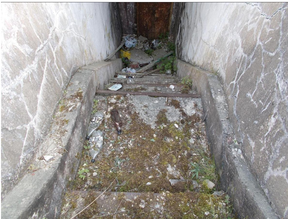
Foto 6. Komandoposti [65] pääseb mööda kahte u 3,5 m kõrgust treppi. Pildil läänepoolne sissekäik, mille rauduks on veel alles. Foto Jüri Pärn 10.06.2015.
