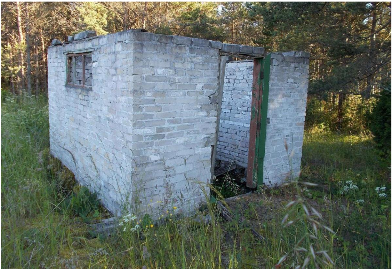
Foto 73. Kemmerg [24] — vaade hoone [19] poolt. Sisu on ära mädanenud, uks vedeleb maas. Hoone vundamendiks on kasutatud kompleksi S-125 rakettide transpordi- ja laadimisseadmete talasid.
