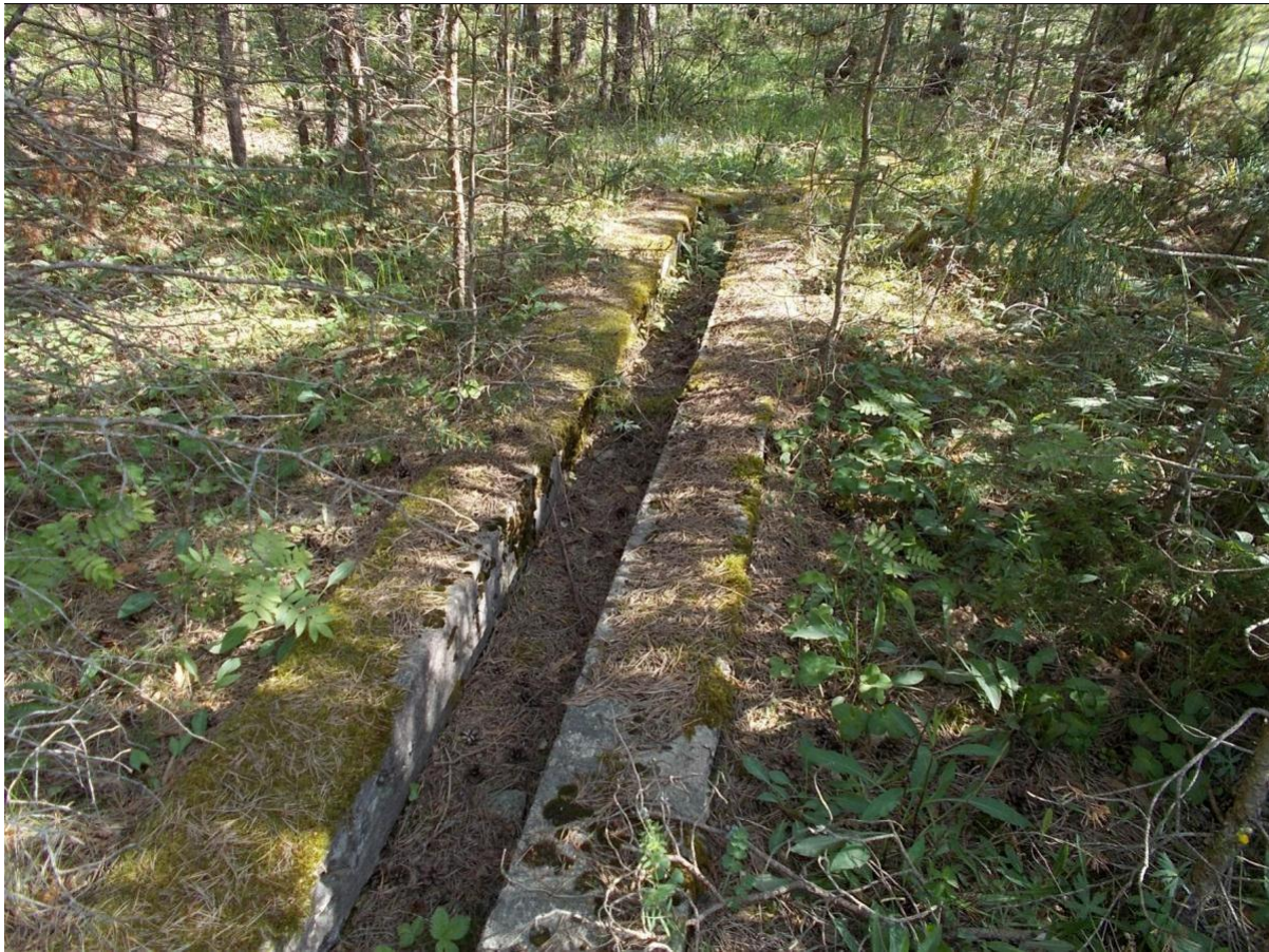
Foto 70. Stardiväljakult [62] viib komandopunktini [66] korralik betoonist valatud kaablikanal. Foto Jüri Pärn 10.06.2015.
