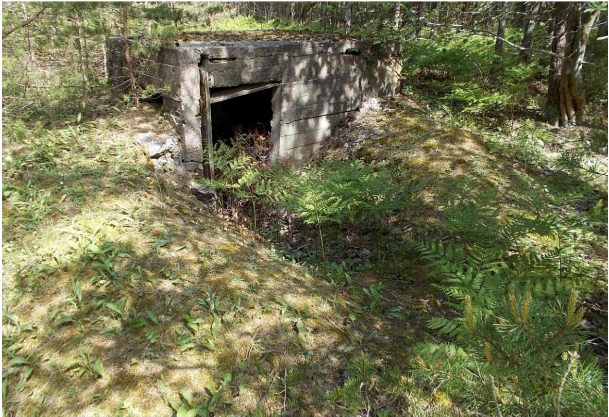
Foto 72. Betoonist valatud riskülikukujuline dott [79] piirivalvekordonisse viiva tee ääres. Foto Jüri Pärn 10.06.2015.
