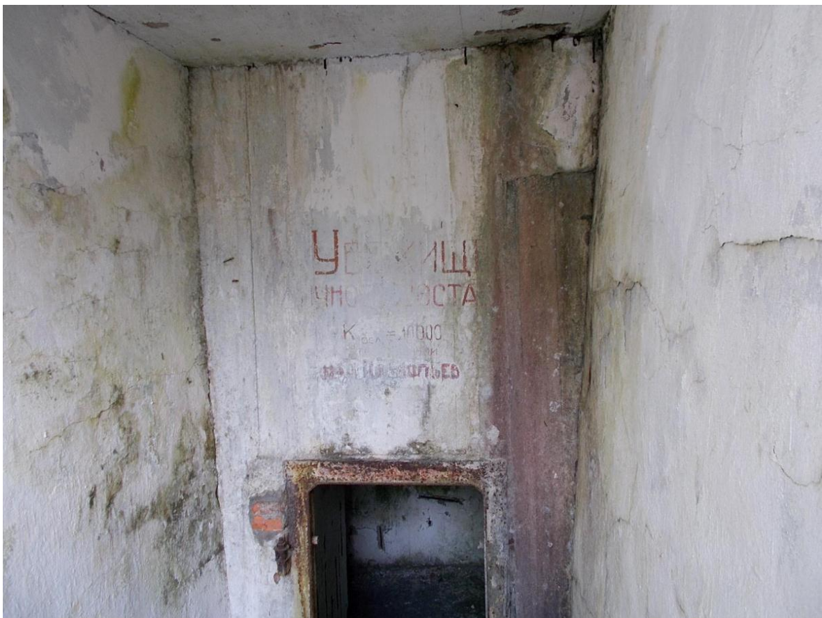
Foto 8. Vana komandoposti [65] kasutas divisjon varjendina. Idapoolse sissekäigu kohal on kiri „Isikkoosseisu varjend / Nõrgenemiskoeffitsient K = 10\,000 ” — küllaltki soliidne number. Foto Jüri Pärn 10.06.2015.
