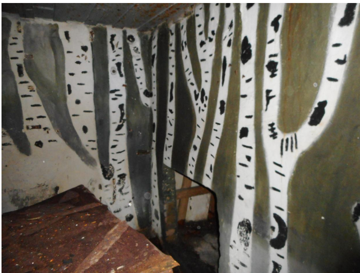
Foto 25. Seinamaaling komandopostis [65], ventilaatoriga ruumis. Tõenäoliselt hilisem, varjendiaegne. Vasakul elektrikalorifeer. Foto Jüri Pärn 10.06.2015.
