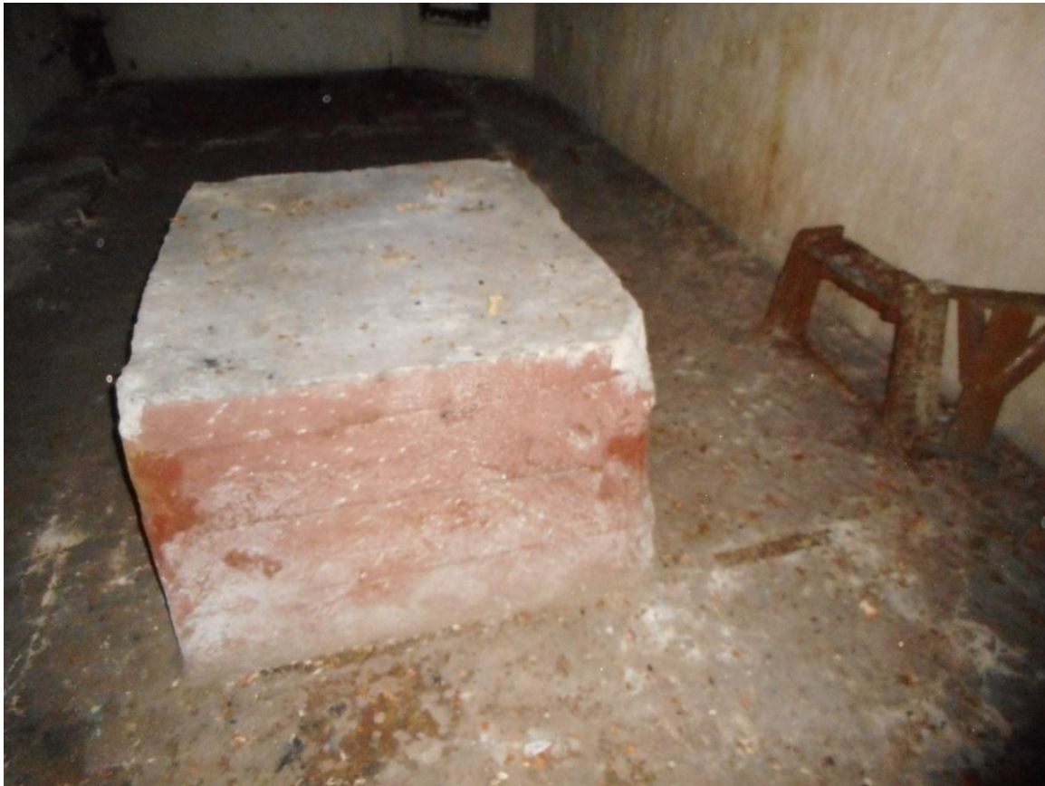
Foto 16. Komandoposti [65] masinaruumi betoon- ja terasalus. Foto Jüri Pärn 6.12.2017.
