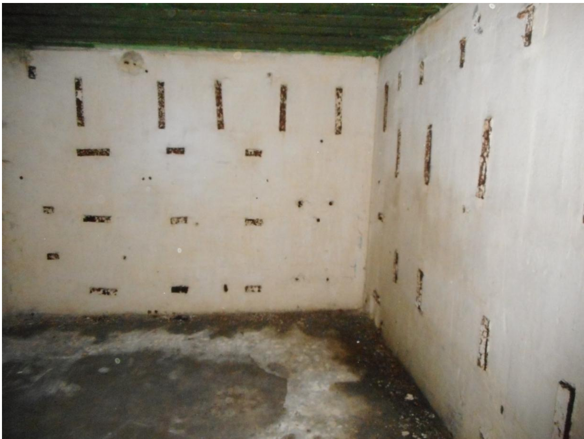
Foto 23. Komandoposti [65] suurima ruumi taga paiknev aparaadiruum. Kõik seinad on kaetud teraslattidest seadmekanduritega. Foto Jüri Pärn 6.12.2017.
