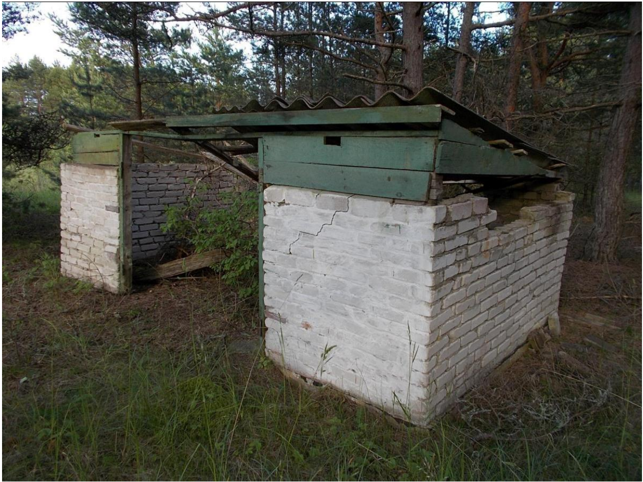
Foto 74. Hoone [17], vaade [19] poolt. Kõrgus seest 1,5–1,8 m. Foto Jüri Pärn 27.06.2015.
