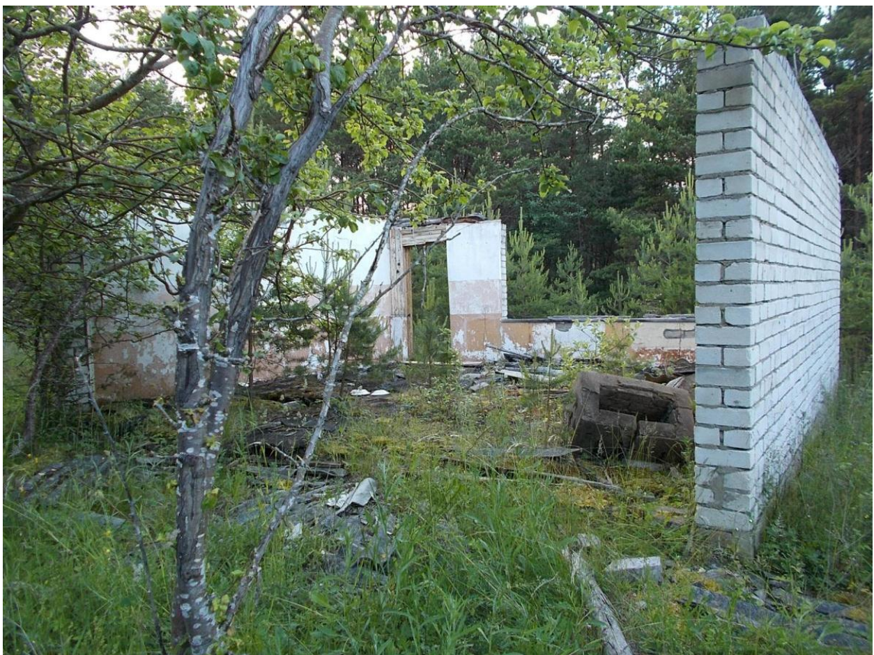
Foto 61. Hoone [11] (kauplus?). Suurema osa esiküljest hõlmab aken. Hoone [11] on ehitatud ligi 4 korda suuremale vanale betoonvundamendile (korralik, kuni 0,9 m lai, kaldus betoonäärisege), mille mõlemas otsas on trepp (oli elamu või kasarmu?, II maailmasõja aegne?). Foto Jüri Pärn 27.06.2015.
