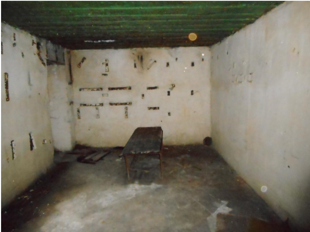
Foto 22. Komandoposti [65] suurima ruumi taga paiknev aparaadiruum. Kõik seinad on kaetud teraslattidest seadmekanduritega. Foto Jüri Pärn 6.12.2017.
