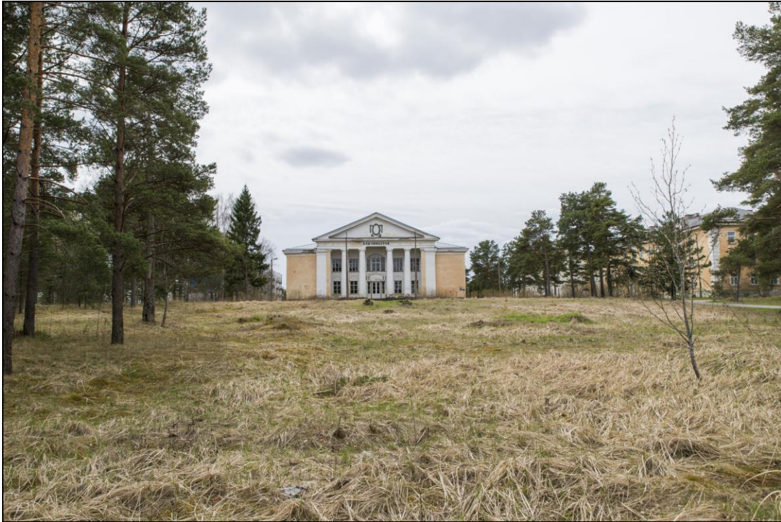
Foto 1 (831). Ohvitseride maja Klooga alevikus, Kivi tn 1. Vaade põhja poolt, Aedlinna teelt. Foto Mart Mõniste 3.05.2018
